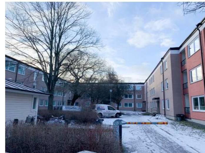
Gårdsrum tillgängligt från gatan.
