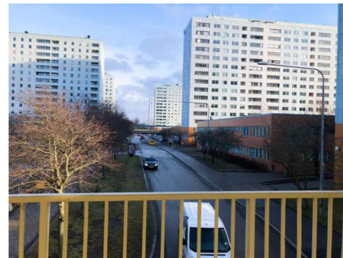
Gångbroar ovanför bilvägarna leder in till bostadsgårdarna.
