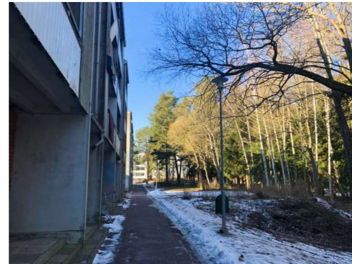
Bebyggelsen (lamellhus) i anslutning till grönstråket och den långsgående gång- och cykelvägen.
