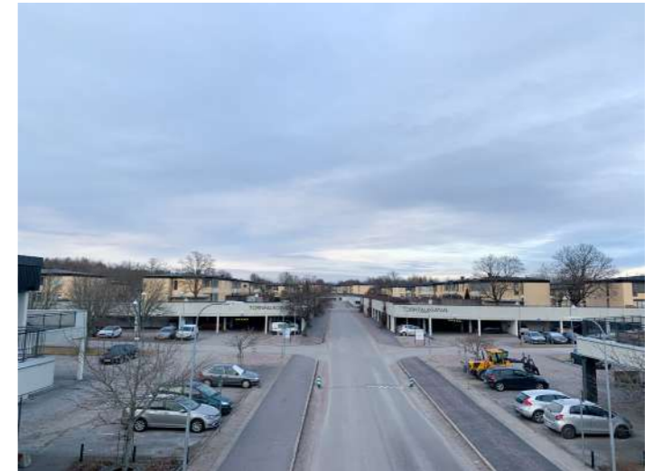
Foto från en av Oxhagens gångbroar med utblick över bilvägen och parkeringsytor. I bakgrunden syns hus och gårdar placerade över öppna parkeringsgarage.
