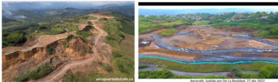
Imagen: Obras en Palestina2022 Fuente: Aeropuerto del Café, y De La Realidad..
