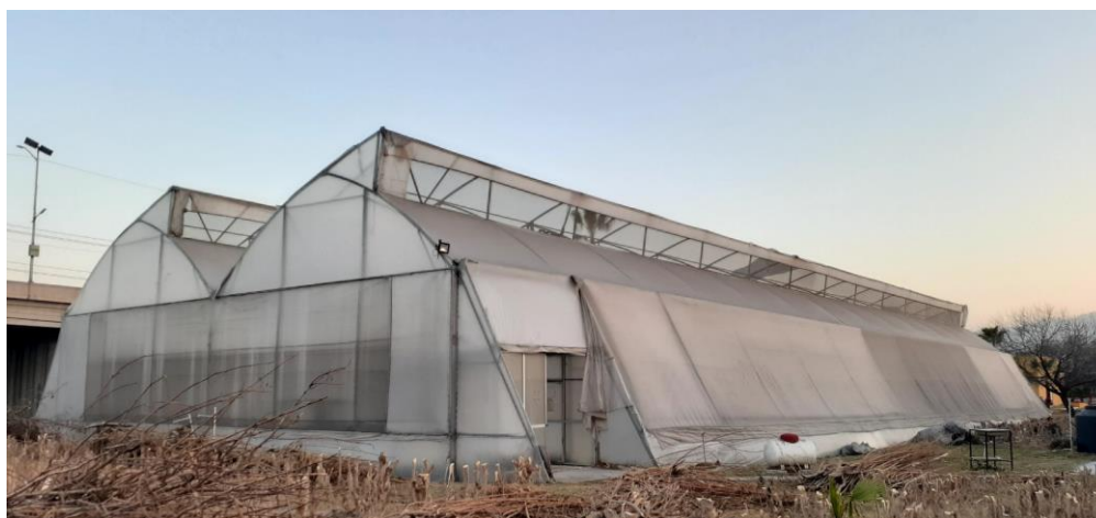
Figura 1. Invernadero tipo gótico del Centro de Agricultura Protegida de la FAUANL.
