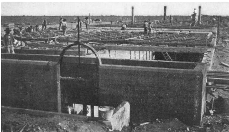
Figura 1. Construcción de la planta tratadora de aguas residuales en General Escobedo, 1908. Tomado de Conway, George Robert Graham (1911).
