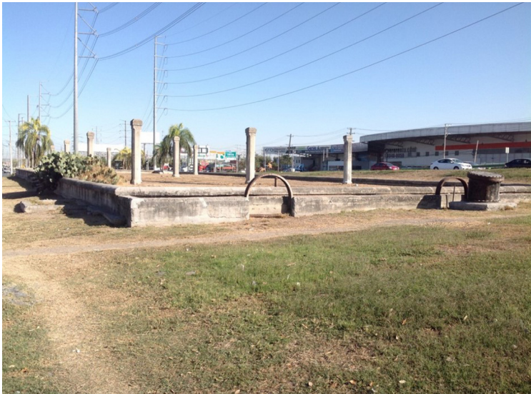
Figura 4. Vista actual de la antigua planta de tratamiento. Imagen tomada por el autor.
