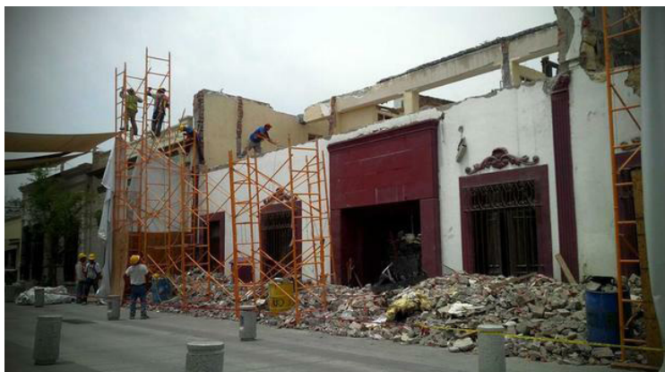
Figura 11. Demolición de casas de principios del siglo XX, Monterrey centro.
