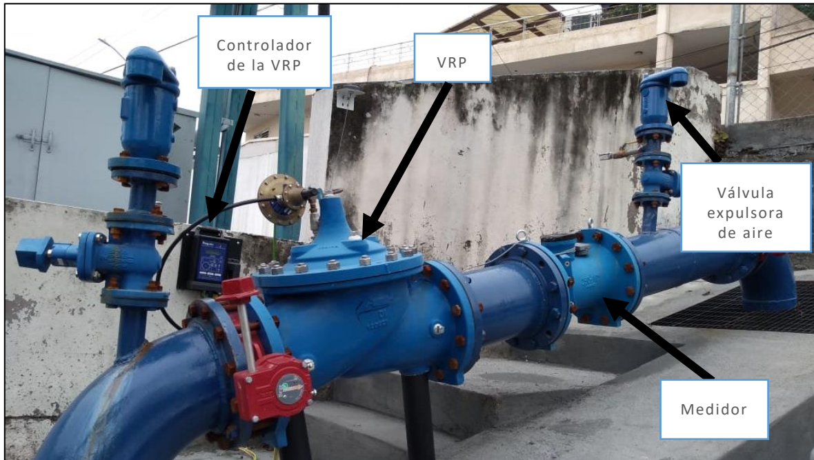
Figura 2-17 Válvula reductora de presiones en sitio (Obtenida en sitio).
