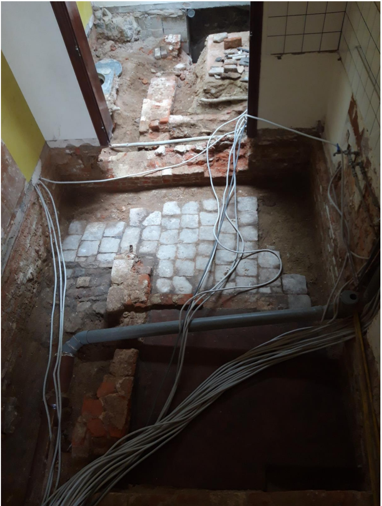
Fig. 27: Zicht vanuit het noorden vanop de trap naar de eerste verdieping.
