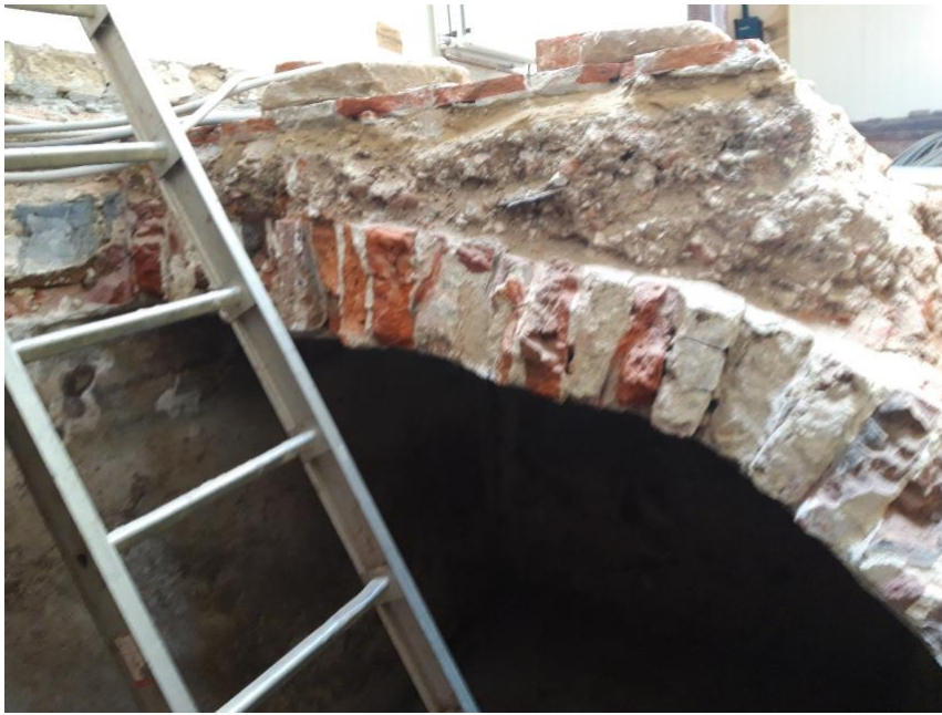
Fig. 28: Zicht op het keldergewelf vanuit een gat in het zuidelijk deel ervan.
