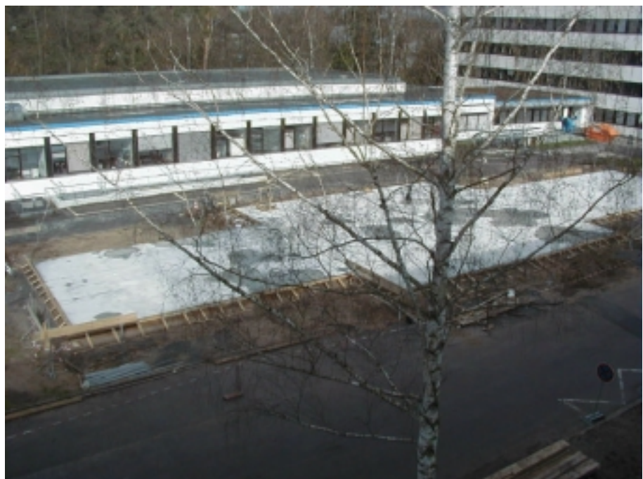
Abb.: Fundament des künftigen Fertigungszentrums.
