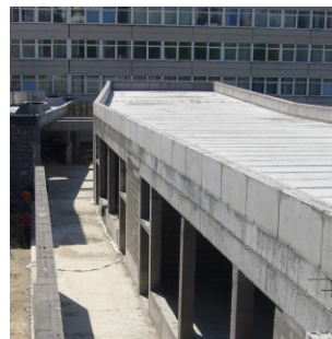
"Pollack" rekonstrukció - 2007 - építés alatt
