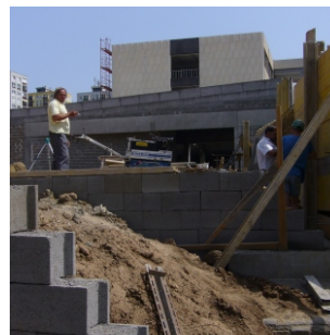
"Pollack" rekonstrukció - 2007 - építés alatt
