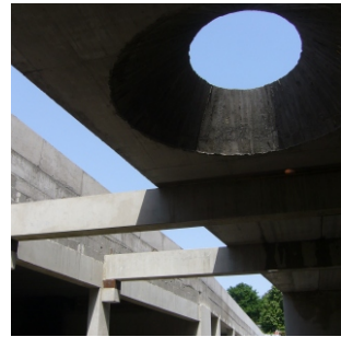
"Pollack" rekonstrukció - 2007 - építés alatt
