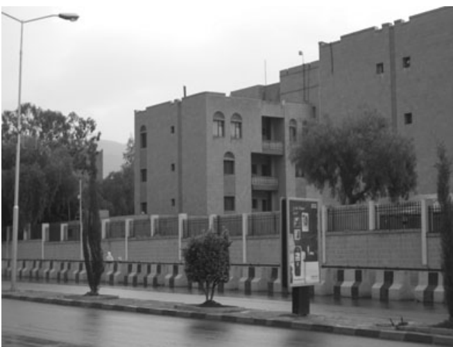
Fig. 2 bis. Hadda Residential Complex, rue /Hadda (sud-ouest de /San'â')
