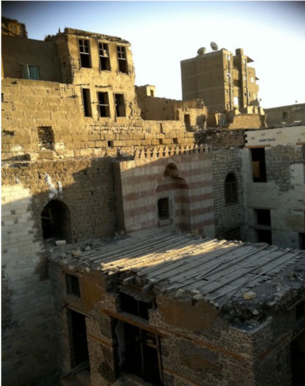
Photo 2 : Darb al Labban, dégradation avancée pour rachat hâtif
