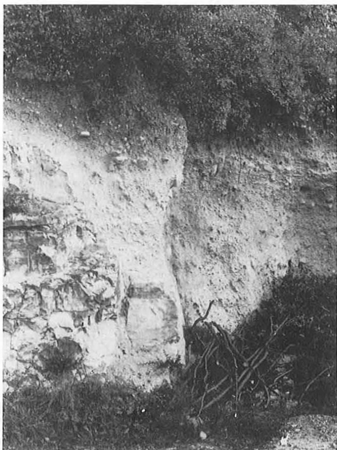
FIG. 3 - Località Brancolino (area di S. Vigilio) contatto per faglia fra calcari oolitici del Giurassico, sulla sinistra, e depositi morenici del Pleistocene superiore, sulla destra, (da CARTON & CASTALDINI, 1988).
