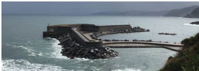
Figura 5.9. Planta de enerxía de Mutriku (Euskadi)
