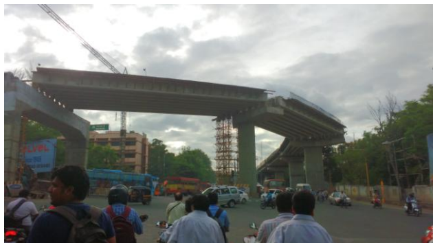
Image 1. Actual Flyover Construction
