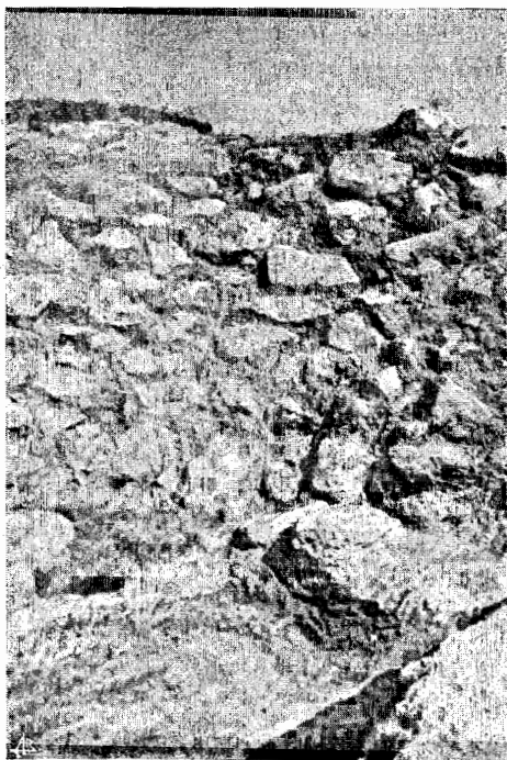
Fig. 7 — Pormenor de construção da muralha junto da cavidade aberta para deitar as varreduras do forno.
