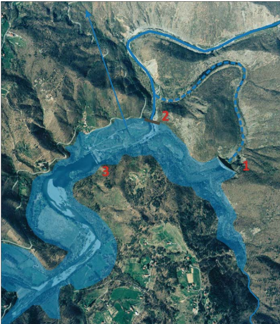
Figura 7 – Fotogramma aereo dell'area di Bric Zerbino (Regione Piemonte, 2000). Risultano visibili: 1) Diga Principale di Bric Zerbino; 2) Taglio in roccia del meandro presso la ex Sella Zerbino; 3) Traversa di Ortiglieto attualmente in uso. La freccia indica la posizione planimetrica della galleria di carico.
