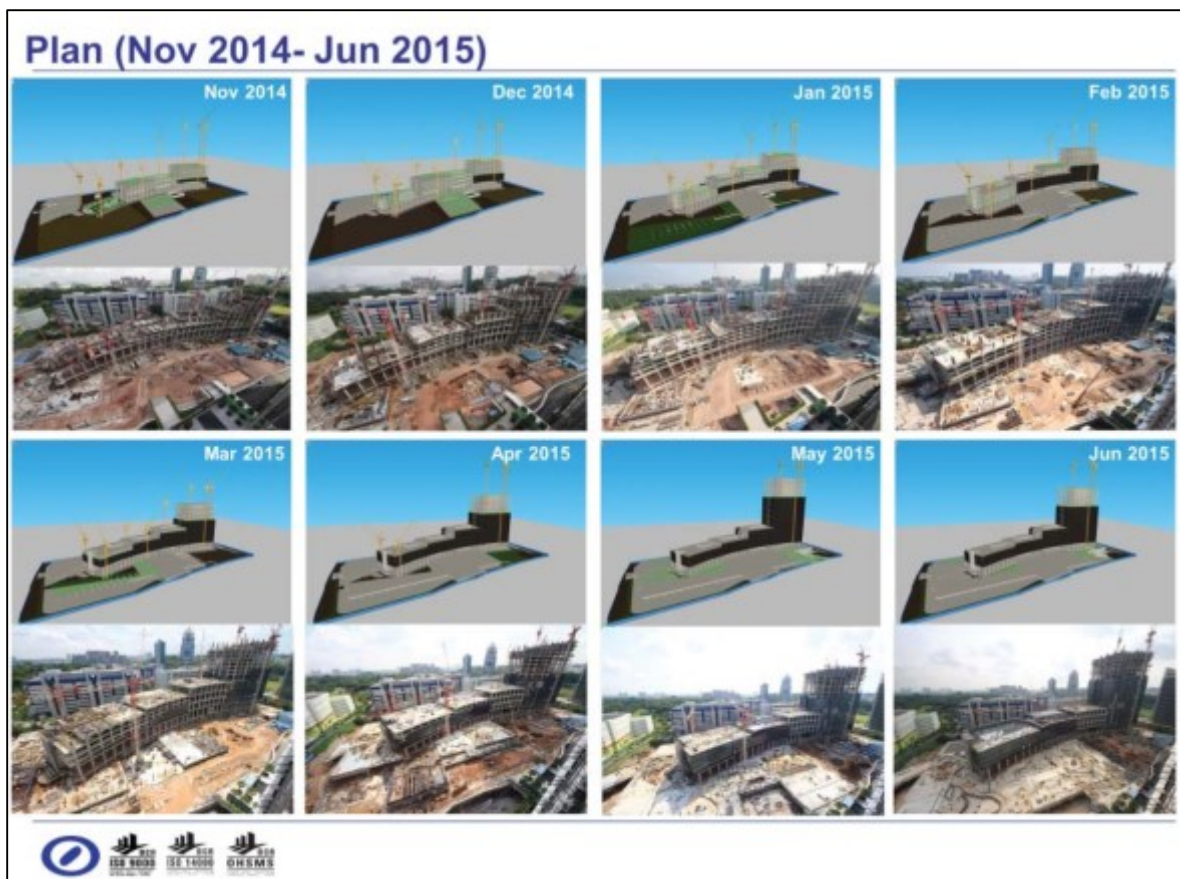
Figura 8. Plan de seguimiento a través de BIM, controlado en 4D al edificio Mapletree Business City II, Singapore. Fuente: BIM Handbook, tercera edición, 2018
