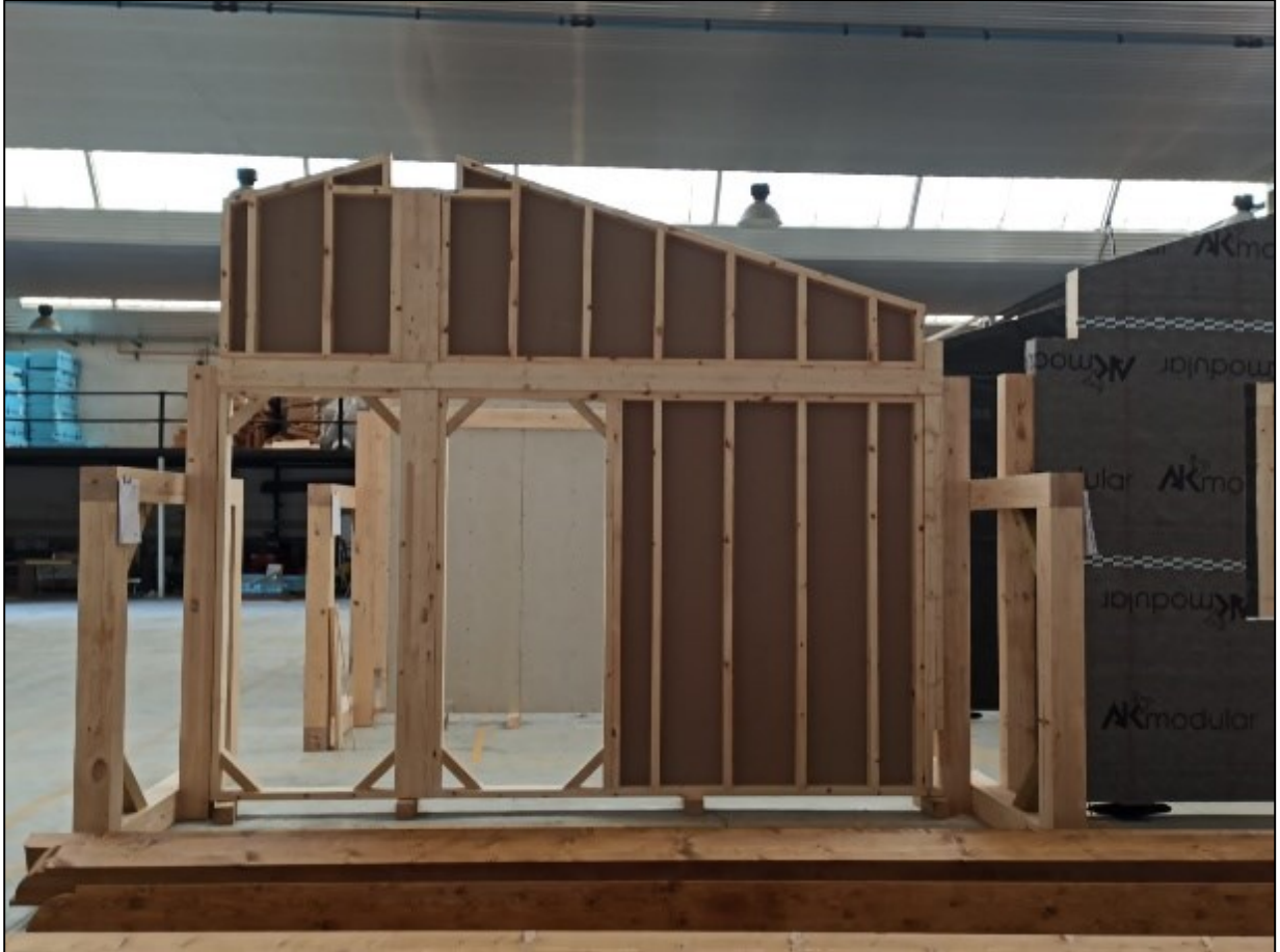
Fotografía 2. Parte del muro A sobre paales, trabajo en ambas caras.
