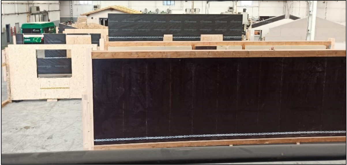
Fotografía 3. Parte del muro A sobre parales, colocación de aislantes
