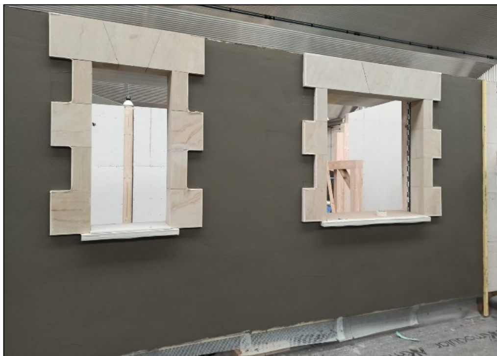
Fotografía 6. Muros con acabados exteriores, sate y piedra en revestimiento.
