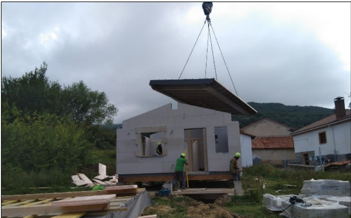
Fotografía 7.Fabricación de la cubierta
