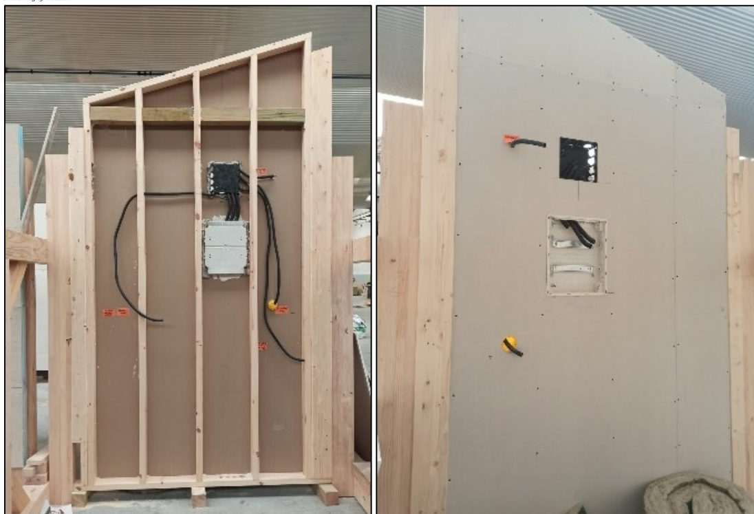
Fotografía 5. Muros con aislantes, pladur y redes principales terminadas, trabajo en ambas caras Se continúa con los acabados de piedra y sate (sistema de aislamiento térmico exterior) por la parte exterior de los muros. Ver Fotografía 6.
