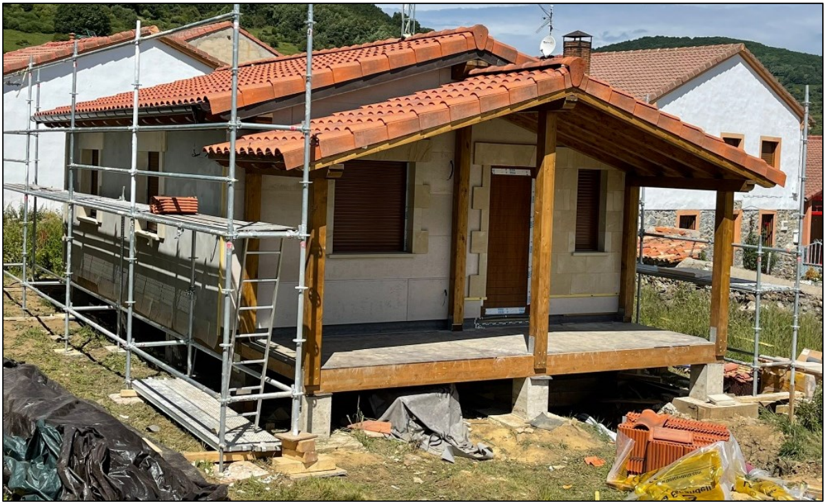
Fotografía 9. Vivienda modular de madera en etapa de finalización
