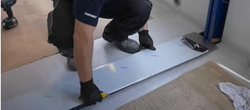
Figura I.36. Colocación de chapa metálica inferior (CONTAINEX, 2015)
