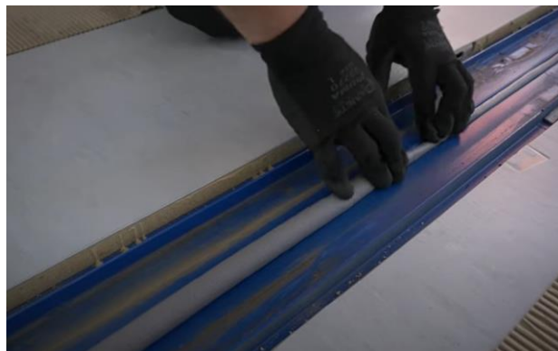
Figura I.35. Colocación de juntas de goma o burletes (2) (CONTAINEX, 2015)
