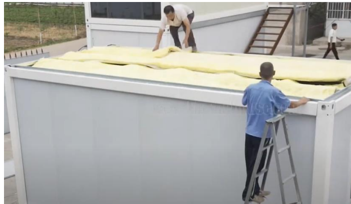
Figura I.18. Colocación del aislamiento en la estructura del techo (K-HOME, 2019)
