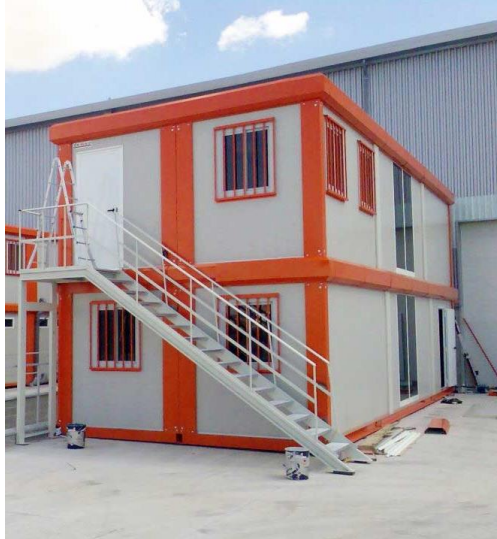
Figura II.38. Empleo de carcasas exteriores a lo largo del perímetro del módulo
