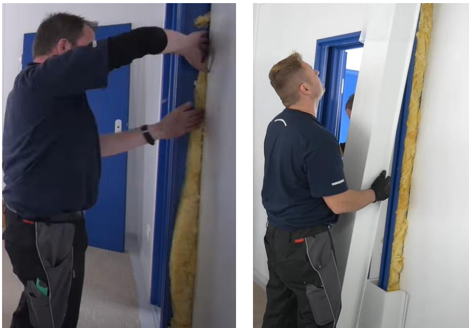
Figura I.37. Colocación de aislamiento extra y carcasa interior (CONTAINEX, 2015)
