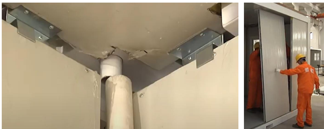
Figura I.16. Colocación de paneles mediante fijaciones (ARCHISPACE, 2020)
