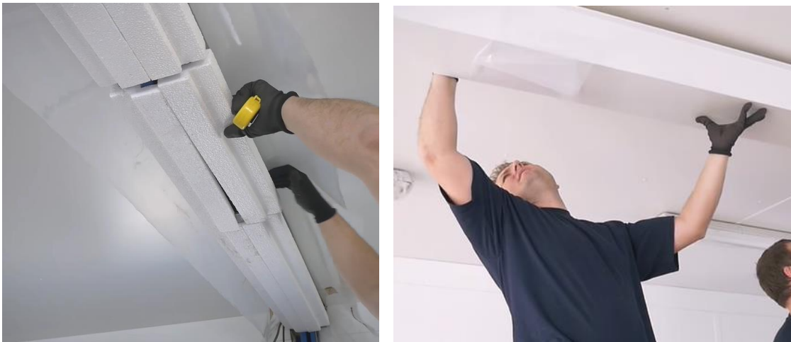
Figura I.39. Colocación de aislamiento extra y carcasa interior (CONTAINEX, 2015)
