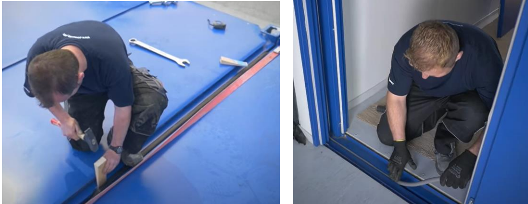
Figura I.34. Colocación de juntas de goma o burletes (CONTAINEX, 2015)
