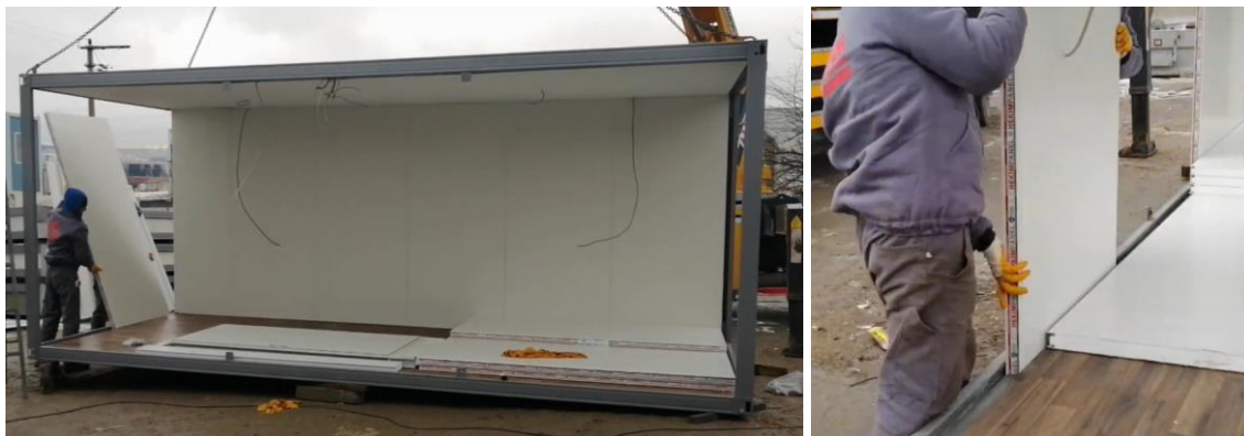
Figura I.15. Colocación de paneles mediante railes (YUVAM, 2020)
