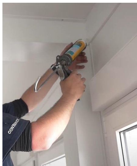
Figura I.40. Remates finales con silicona (CONTAINEX, 2015)
