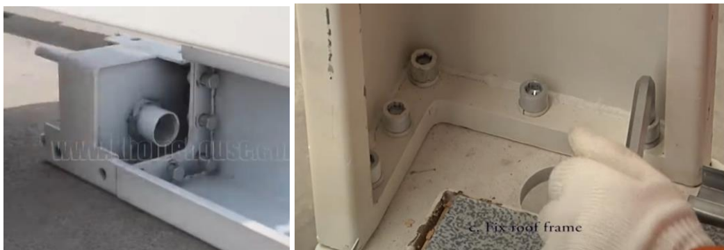
Figura I.9. Unión atornillada por dentro (K-HOME, 2019) (ARCHISPACE, 2020)
