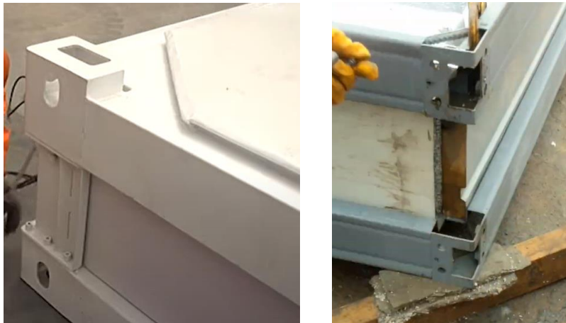
Figura I.6. Uniones soldadas (ARCHISPACE, 2020) (YUVAM, 2020)
