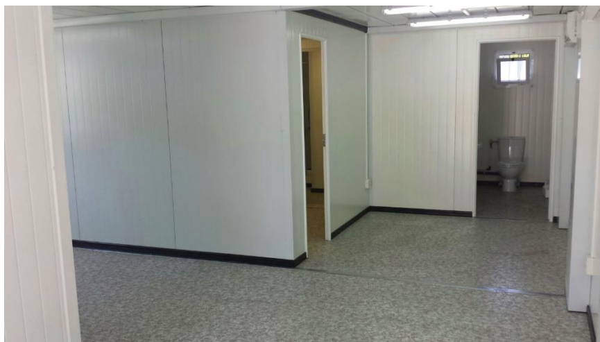
Figura I.23. Particiones interiores en conjunto modular
