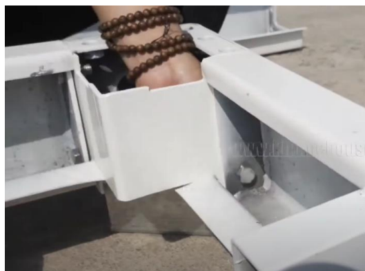
Figura I.7. Unión atornillada (K-HOME, 2019)
