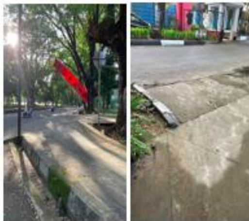
Figure 17. Unhas Tamalanrea Campus Ramp Path
