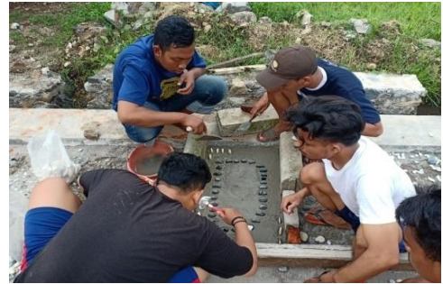
Gambar 3.2 Penataan dan pembuatan pola jalan refleksi
