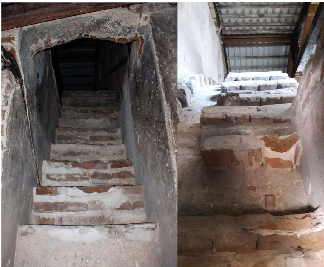
Figura 32 e 33 - Escadas para o forro do transepto e acesso a Cúpula
