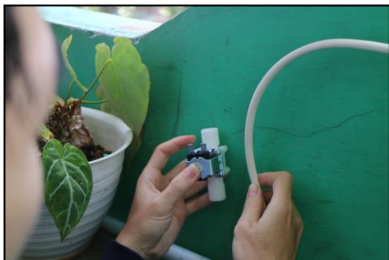
Gambar 8 Pemasangan Solenoid Valve
