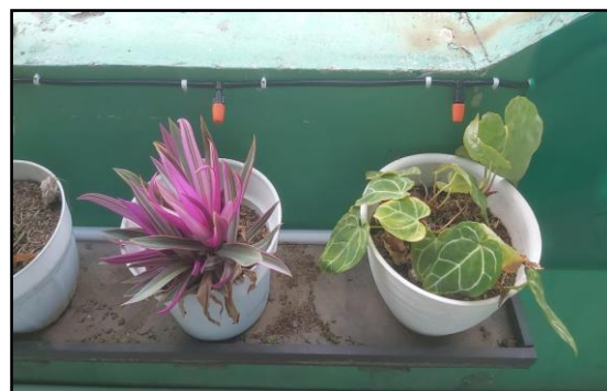
Gambar 7 Pemasangan Nozzle
