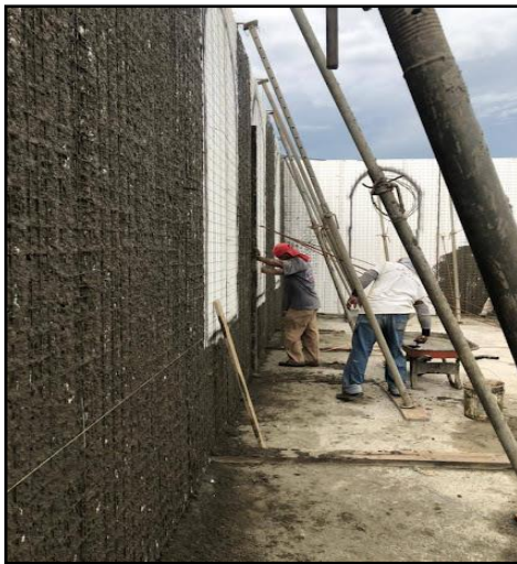
Ilustración 53 chilateo en Paredes PCH-80
