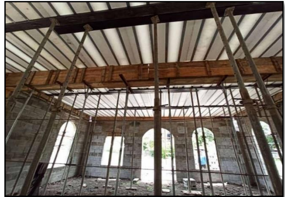
Ilustración 45 Formaleta y apuntalamiento
