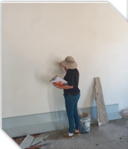
Ilustración 57 Revisión y recepción de acabado
