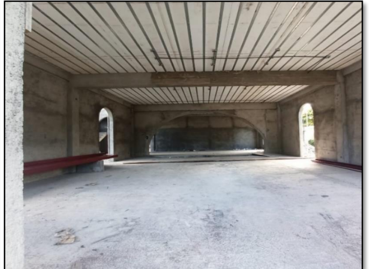
Ilustración 49 Desencofrado de losa, 28 días
