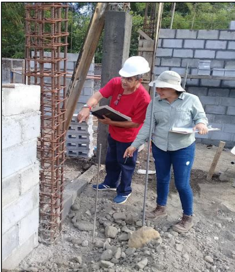
Ilustración 39 Revisión y recepción en acero columnas
