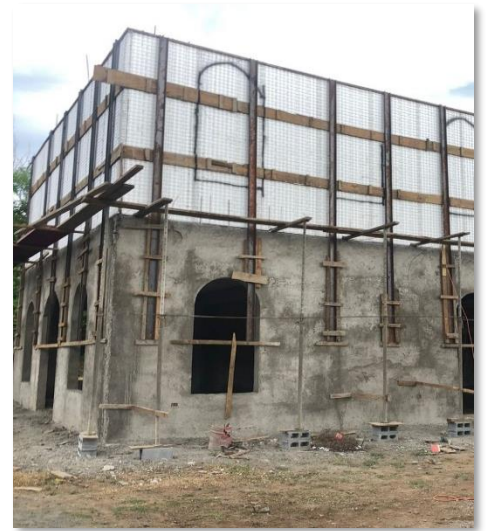
Ilustración 51 Instalación de Paneles PCH-80
