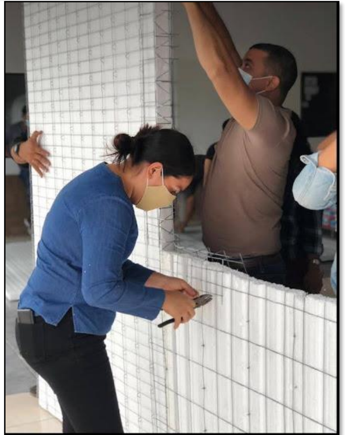
Ilustración 55 Práctica de Instalación PCH-80
