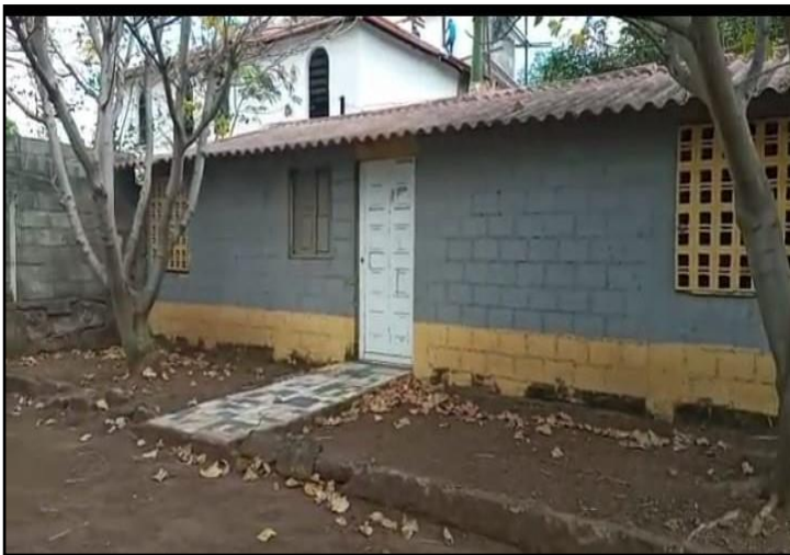
Ilustración 64 Vista Este, conecta a casa Cural
