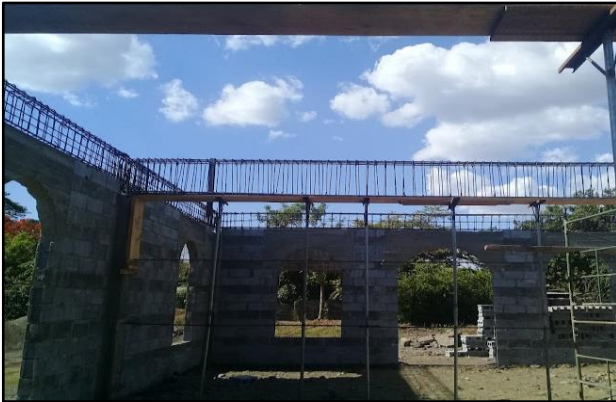
Ilustración 46 Revisión y recepción de armado de VE-200x500/300x700
