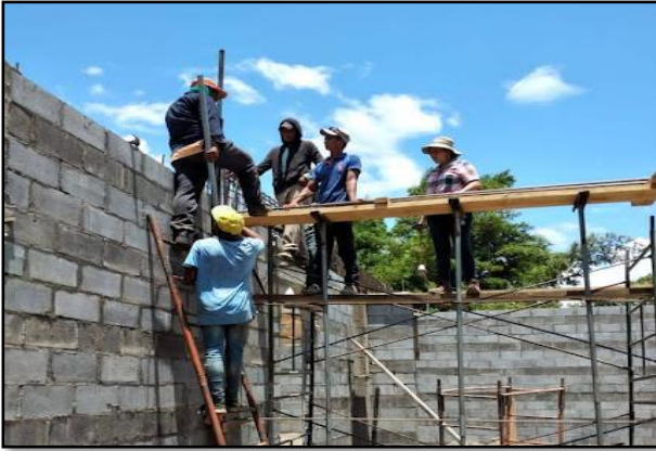
Ilustración 43 Armado de VE 200x500/300x700
