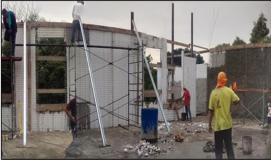
Ilustración 52 Fundido de Concreto en VC-140x150, Puertas y Ventanas
