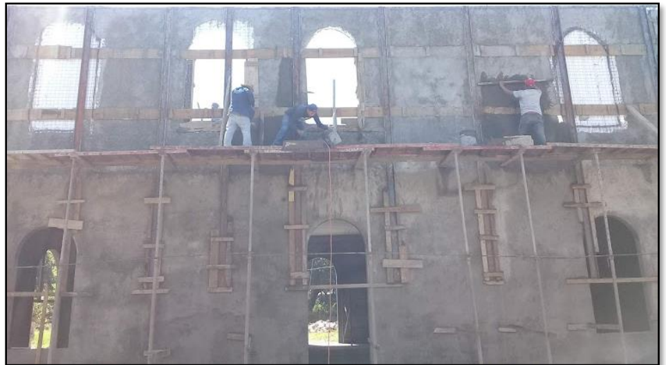
Ilustración 54 Repello en Paredes PCH-80
