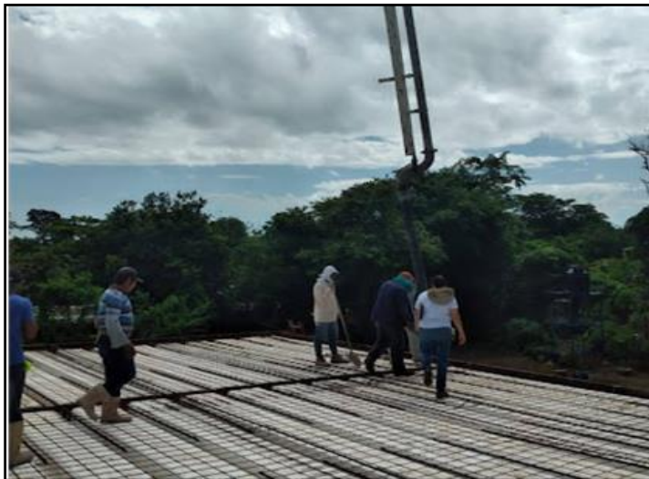
Ilustración 48 Fundido de concreto en VE, Losa entepiso
