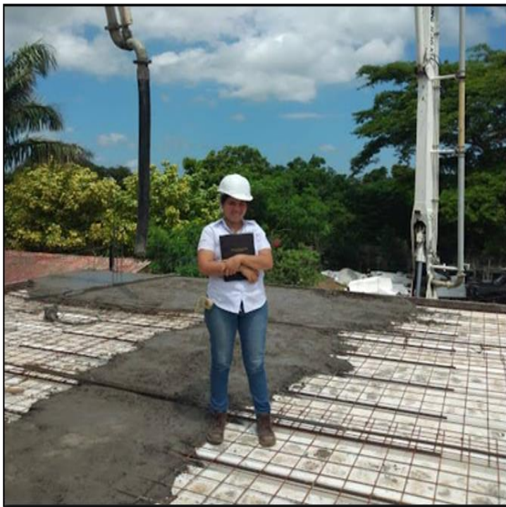
Ilustración 13 Colado de concreto en VE, Losa de entepiso
