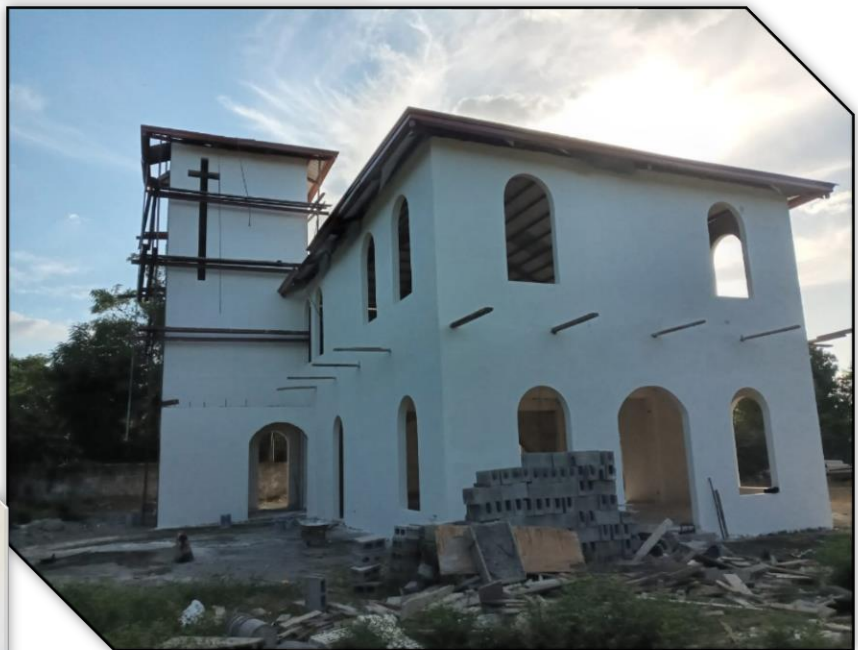
Ilustración 59 Acabado en paredes con repemax
