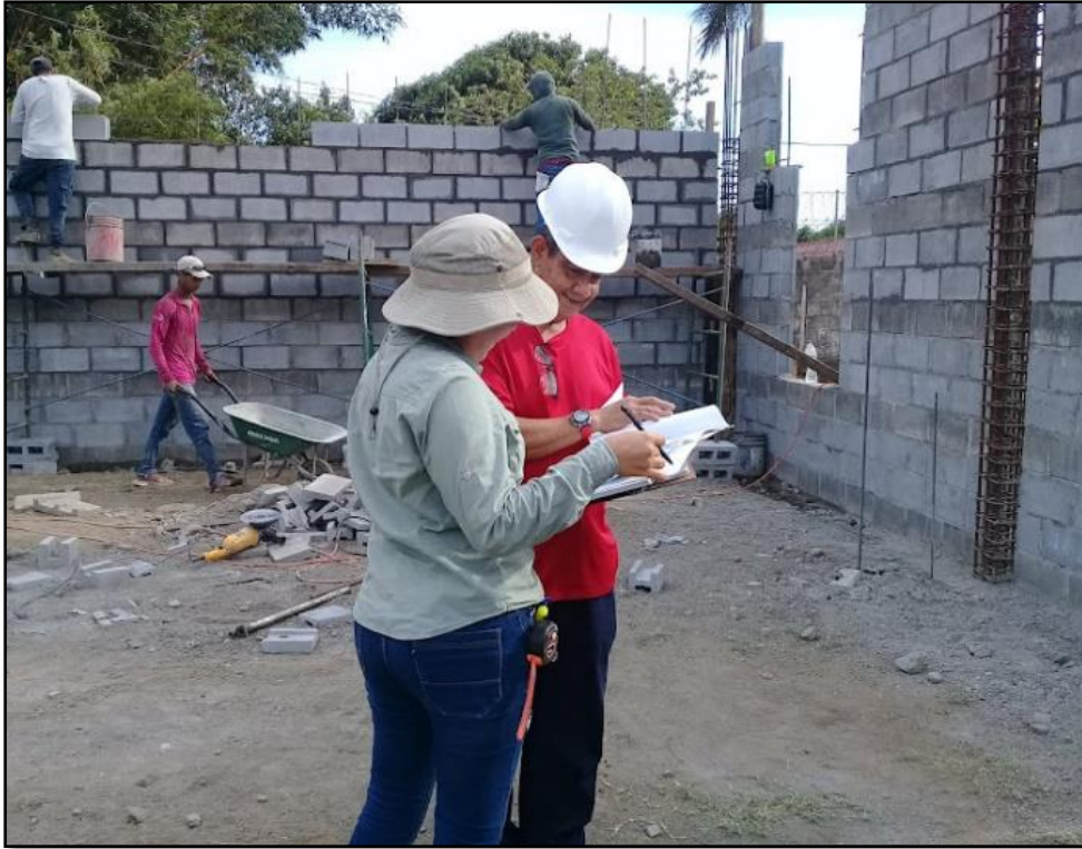
Ilustración 41 Revisión y recepción de mampostería
