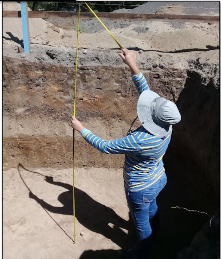
Ilustración 37 Revisión y recepción en Fundaciones
