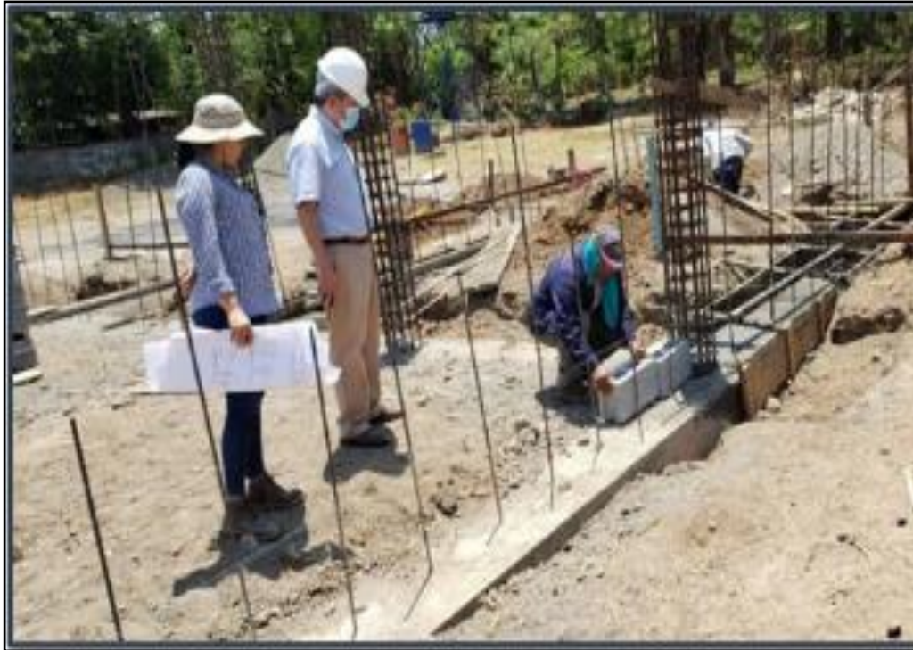
Ilustración 40 Revisión y recepción acero estructura de Concreto
