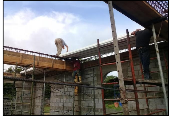
Ilustración 44 Instalación de losa lite
