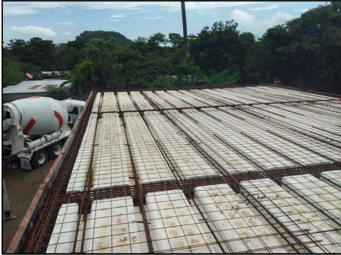
Ilustración 50 Armado de acero en entepiso
