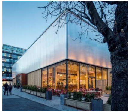
Imagen 139: Muro cortina / Policarbonato. Fuente: Plataforma Arquitectura
