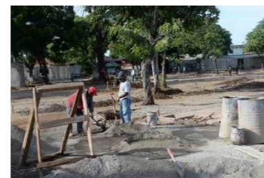
Imagen 252: Construcción. Fuente: La Prensa, 2016
