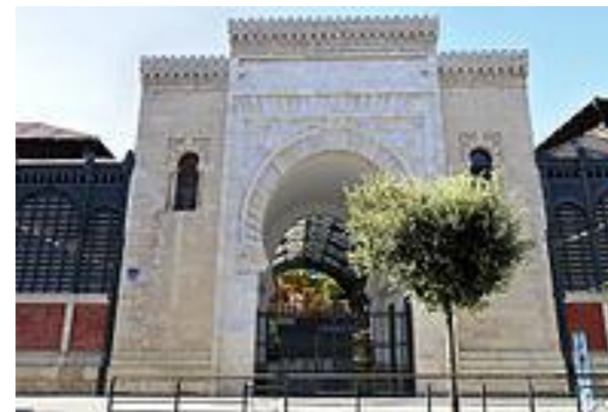
Imagen 166: Fachada principal. Fuente: Plataforma Arquitectura
