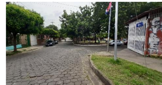
Imagen 46: Cuneta en calle adoquinada. Fuente: Villalobos, J., Torres, L. & Castillo, A. (2021)
