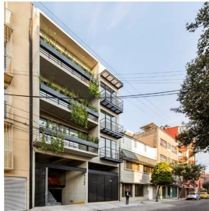
Imagen 299: Edificio Monte Albán 523. Fuente: Plataforma Arquitectura
