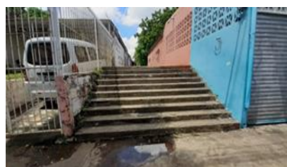
Imagen 61: Acceso Peatonal. Fuente: Villalobos, J., Torres, L. & Castillo, A. (2021)
