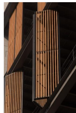
Imagen 339: Celosías. Fuente: Plataforma Arq.
