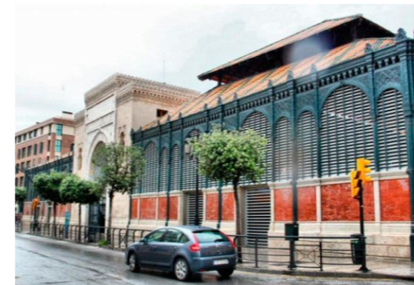
Imagen 156: Mercado Municipal de Atarazanas. Fuente: Plataforma Arquitectura
