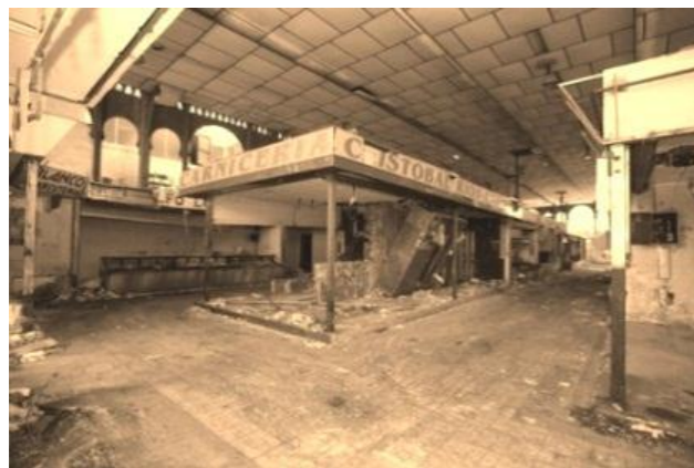
Imagen 162: Antes de la intervención. Fuente: Plataforma Arquitectura
