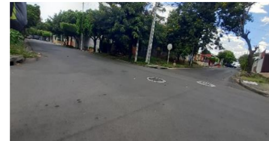
Imagen 44: Drenaje Pluvial en intersección. Fuente: Villalobos, J., Torres, L. & Castillo, A. (2021)
