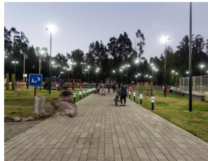
Imagen 199: Caminera. Fuente: Plataforma Arquitectura
