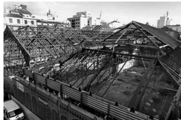
Imagen 161: Rehabilitación de los techos. Fuente: Plataforma Arquitectura
