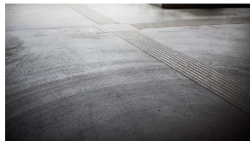
Imagen 142: Piso de concreto Pulido. Fuente: Plataforma Arquitectura
