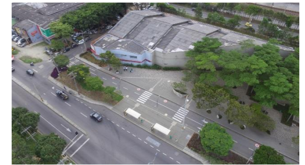
Imagen 182: Antigua Bodega. Fuente: Plataforma Arquitectura
