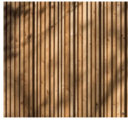
Imagen 141: Listones verticales. Fuente: Plataforma Arquitectura
