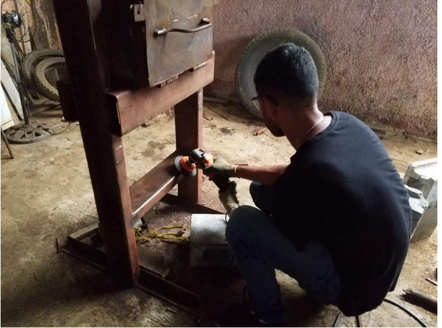
Eliminando escorias y puliendo la estructura.
