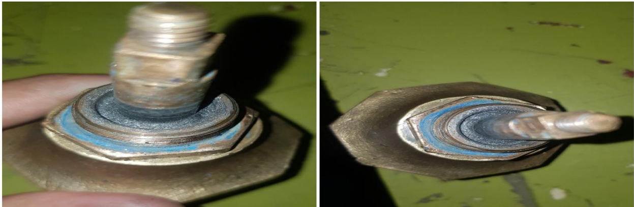
Figura 47: Aplicación del empaque grafitado a la válvula.
