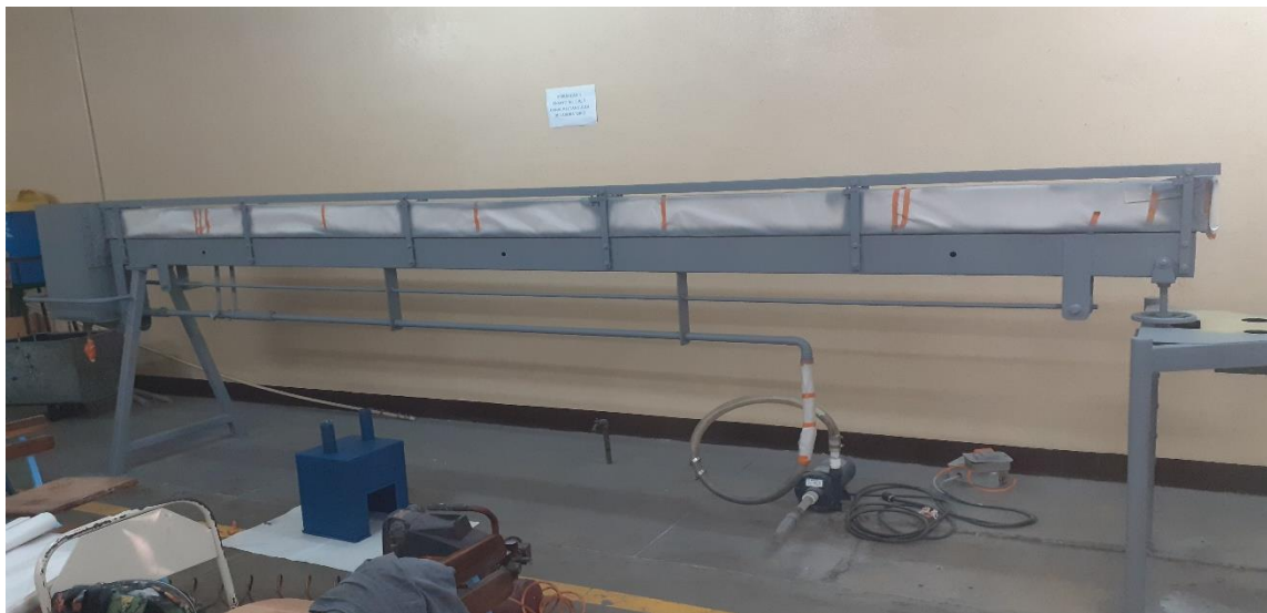
Figura 49: Aplicación de pintura base a la estructura del canal hidráulico
