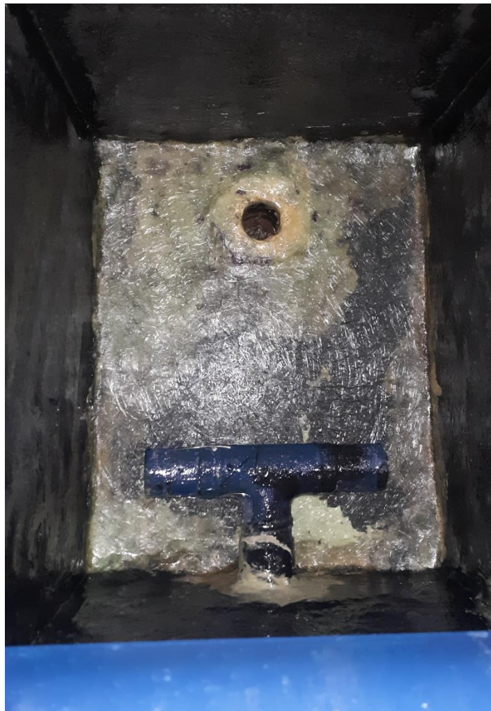
Figura 30: Aplicación de la fibra de vidrio.
