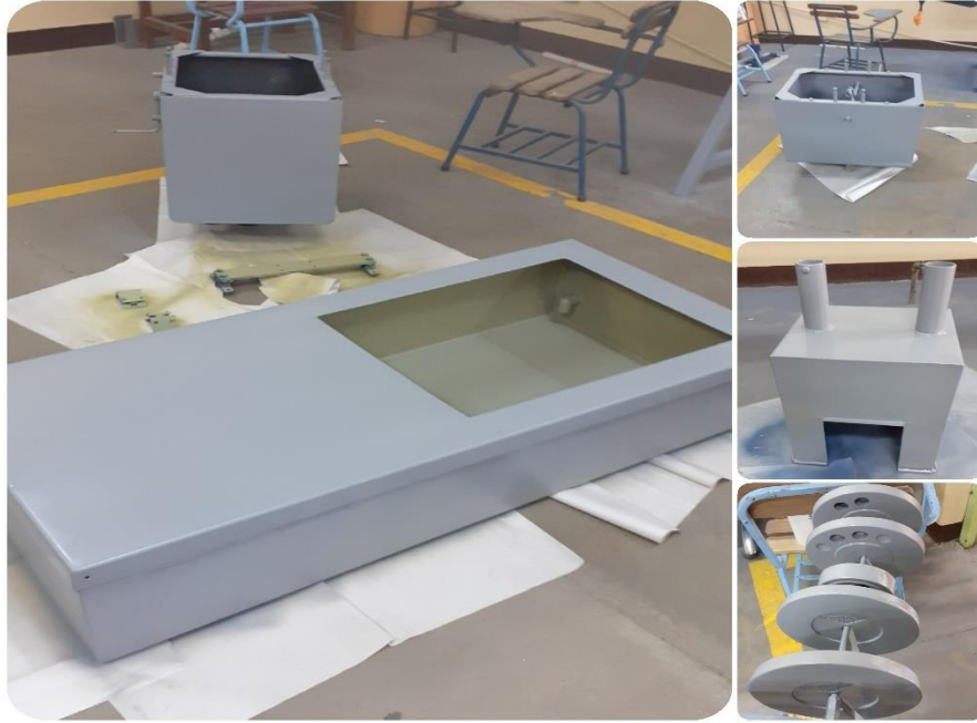
Figura 50: Aplicación de pintura base a los diferentes tanques y accesorios.
