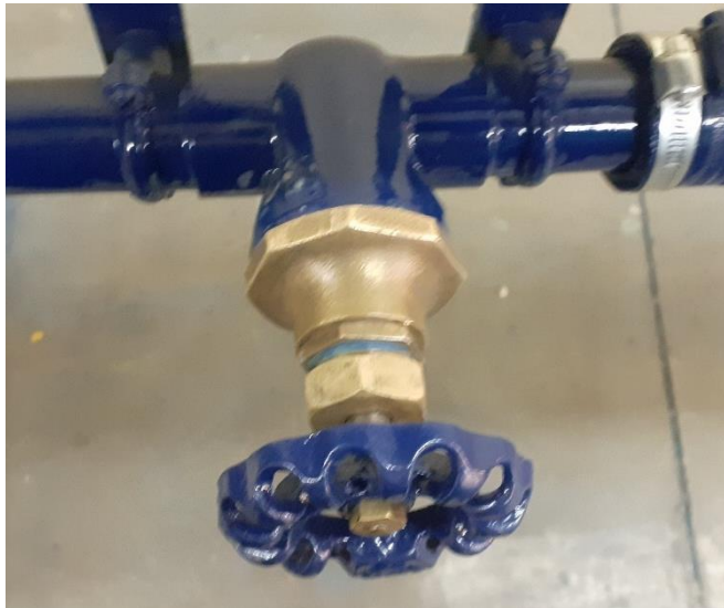
Figura 48: Válvula reguladora de caudal ya instalada.
