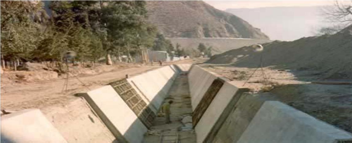
Figura 2 Canal artificial de sección transversal trapecial.
