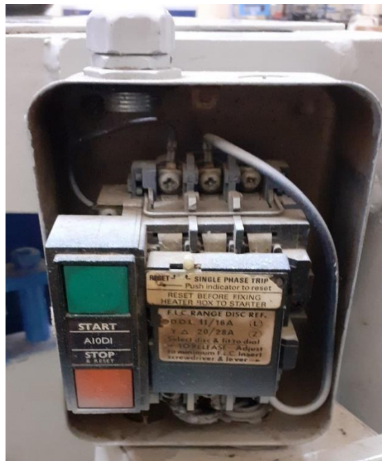
Figura 26: Sistema de arranque manual del motor.
