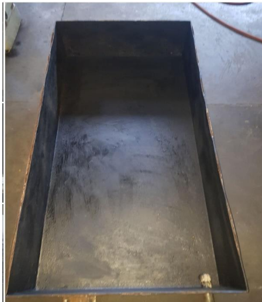
Figura 29: Aplicación de anti gravilla en el tanque cisterna.
