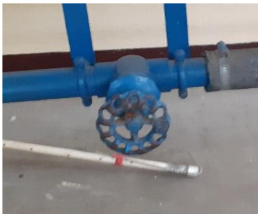
Figura 28: Válvula de compuerta de cuña sólida.
