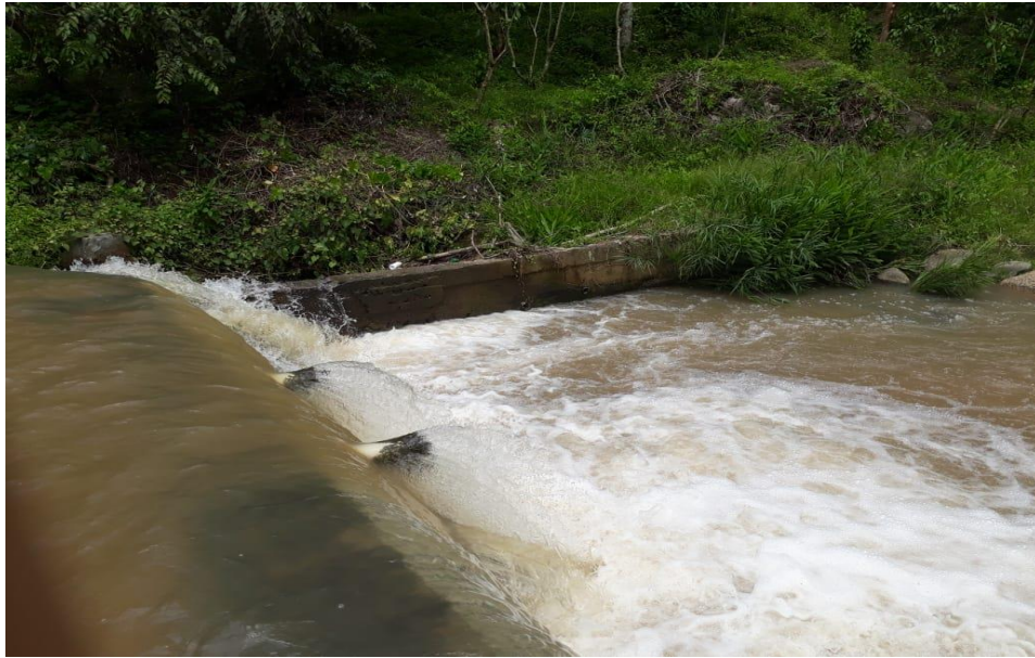
Ilustración 9. Captación actual del sistema
