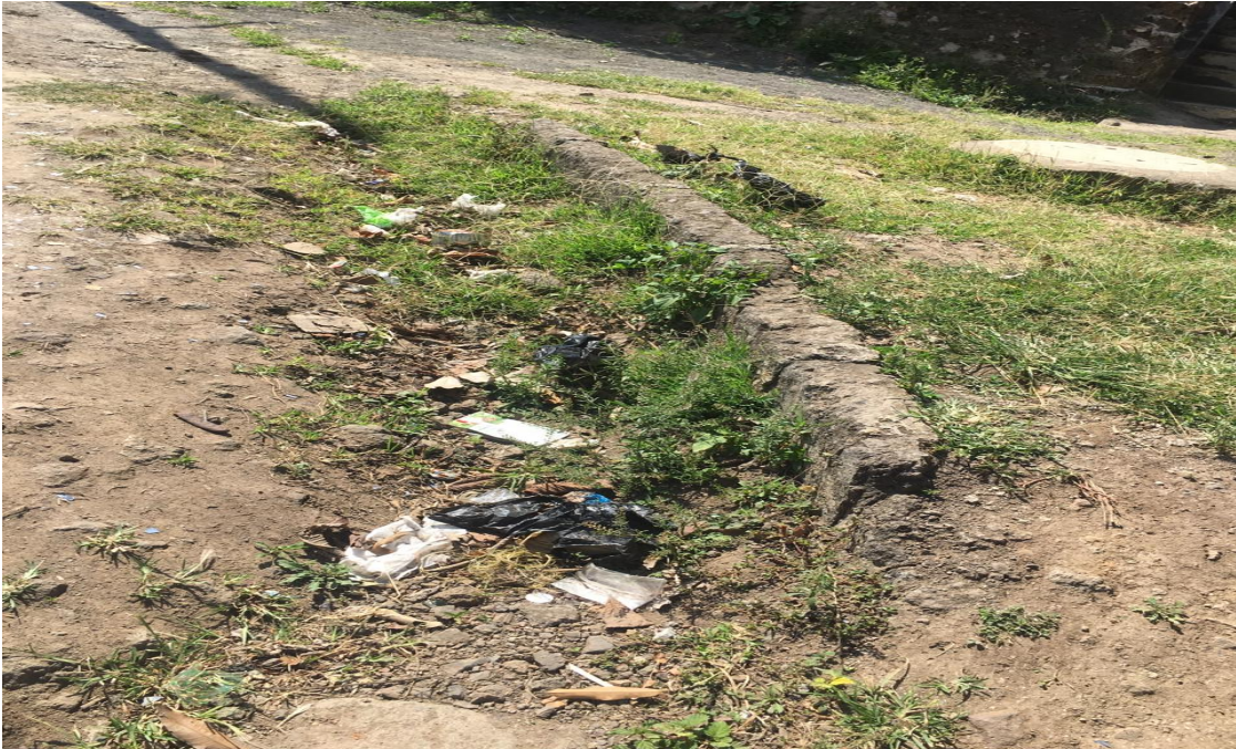
Fotografía 4: Bordillos existentes (Calle principal)
