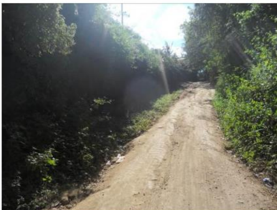
Pm39 a pm40. Evidencia de erosión. Rasante actual de camino vulnerable a erosión hídrica y contaminación por desechos sólidos. Revestir camino y construir cunetas.
