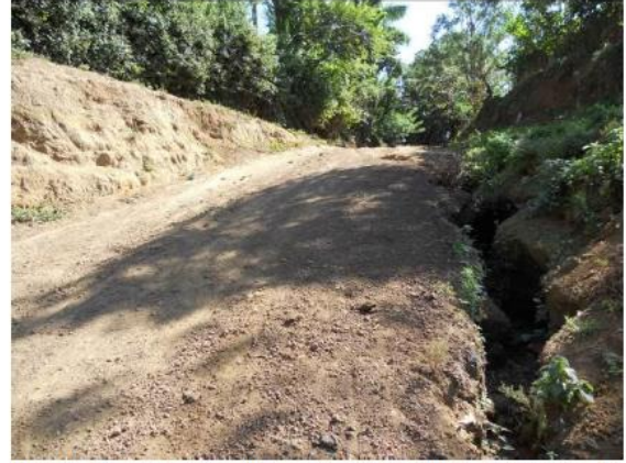
Pm21. Tramo vulnerable a erosión hídrica. Evidencia de erosión fuerte en surco con profundidad de 80cm. Reconstruir sección de camino, compactar adecuadamente y revestir calzada con concreto hidráulico, construir cunetas.
