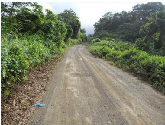
Pm1. a 130m de empalme El Boquete. Sección angosta. Escarpe a ambos lados.
