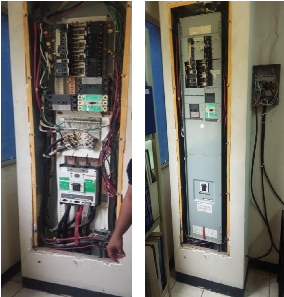
Foto. 3. Panel principal Biblioteca planta baja.
