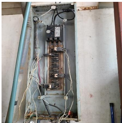
Foto. 5. Paneles Eléctricos en malas condiciones
