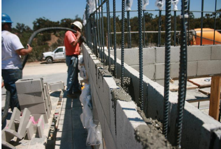
Figura 2.2 Inyección de concreto líquido de un muro de mampostería reforzada (Gregory Kingsley, Benson Shing, 2014)
