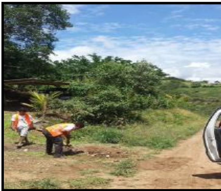
Figura 3: Inicio del Trazo, se observa la presencia de suelos finos
