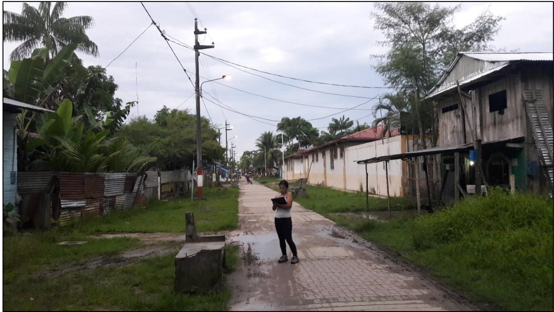
Foto N° 09. Levantamiento de características de Edificación, Isla Santa Rosa, Distrito de Yavarí, Perú
