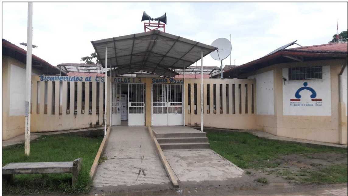
Foto N° 08. Centro de Salud, Isla Santa Rosa, Distrito de Yavarí, Perú
