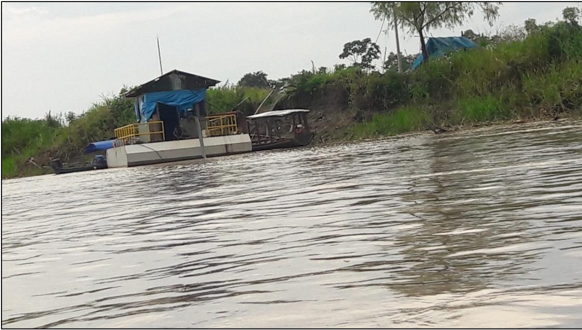
Foto N° 21. Sistema de agua por bombeo desde el Río Amazonas para consumo, Isla santa Rosa, Distrito de Yavarí, Perú.
