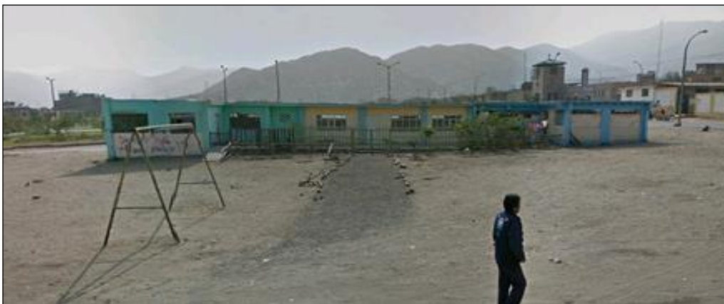
Figura 5. Centro de educación inicial en estado de abandono.
