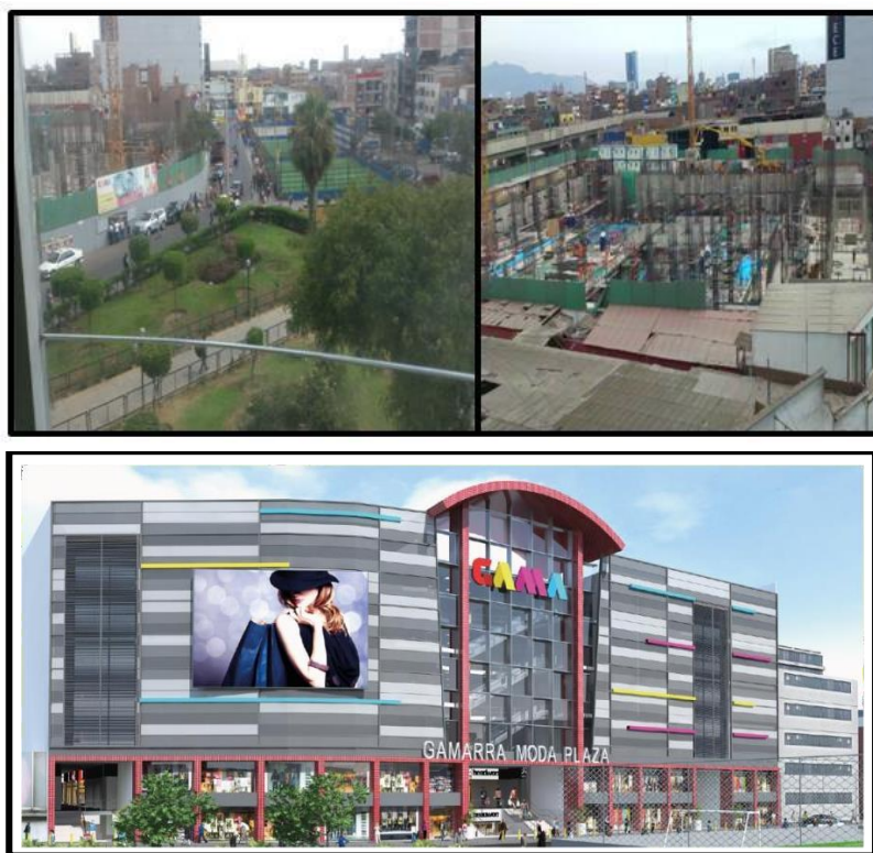
Figura 24. Proyección y construcción del Mall "GAMA. Gamarra Moda Plaza"
