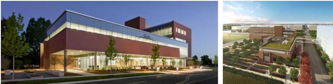
Figura 31. Vista exterior del Centro de Salud y Bienestar Anschutz. Fuente: Web Oficial CannonDesing.
