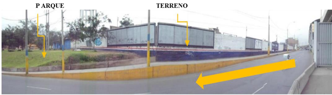
TERRENO: Funciona como depósito de camiones de la Municipalidad de S.J.L
