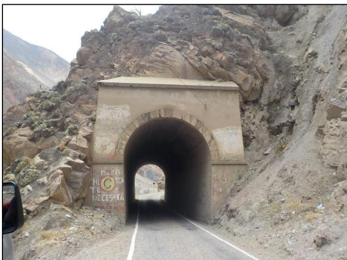
La superficie interna revestida del túnel, no presenta fisuras, si lo hubiera sería el reflejo de la deficiencia de la roca donde se construyó el túnel, lo cual no ocurre, además ello impide que en época de lluvias, filtre la escorrentía formada causando problemas de inundación al piso de la cavidad, que es al mismo tiempo la calzada para los vehículos
