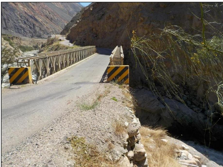
El puente se apoya en muros de concreto asentados en material rocoso en ambos lados, ello indica que casi no es posible algún proceso de socavación, a pesar de la velocidad del flujo, pero los materiales depositados en el cauce deben ser limpiados
