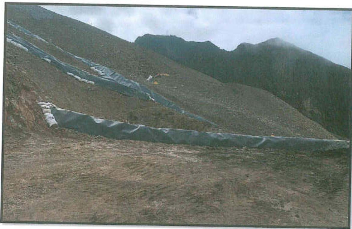
Fotografía N°4: Vista de muro perimetral y canal interno de geomembrana.
