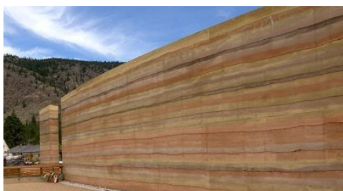
Figura 96: Muro de Tapial Fuentes: www.comeca.com
