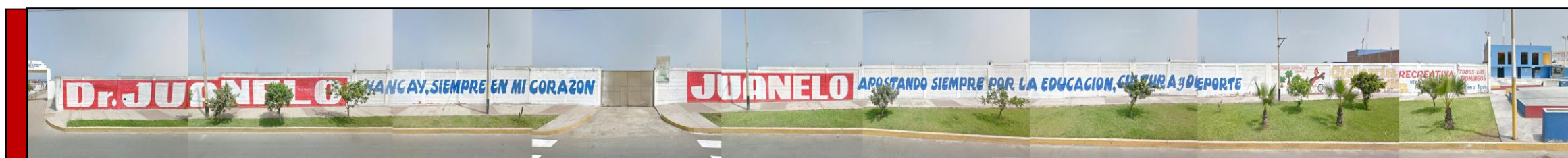
Nota. La figura muestra la fachada del terreno seleccionado. Fuente: Elaboracion propia
