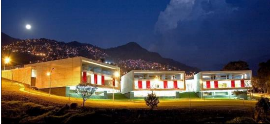
Figura 11: Fotografía del Parque Biblioteca León de Grieff
