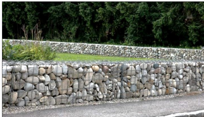
Figura 74: Fotografía de muro gavión
