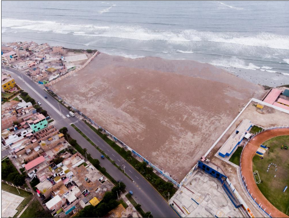
Figura 57: Fotografía del terreno 04
