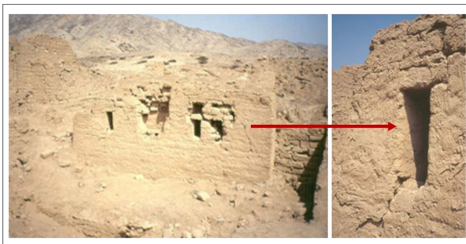
Figura 70: Detalle de ingreso de luz natural
