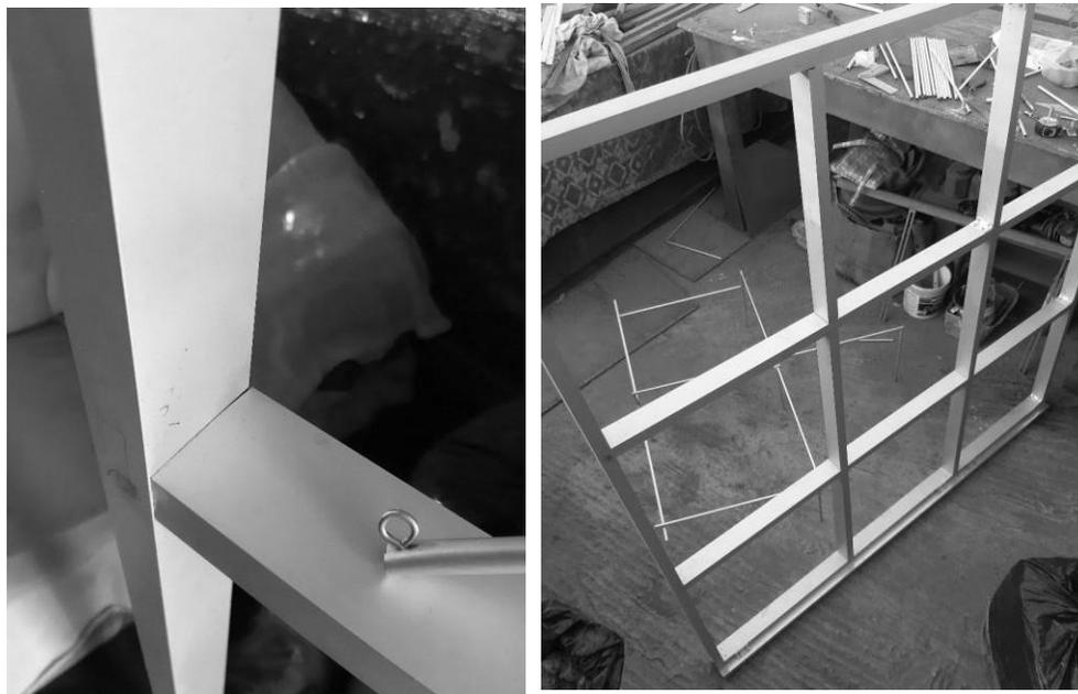
(Figura 18.4). Proceso constructivo de la 1ra capa de la fachada dinámica.
