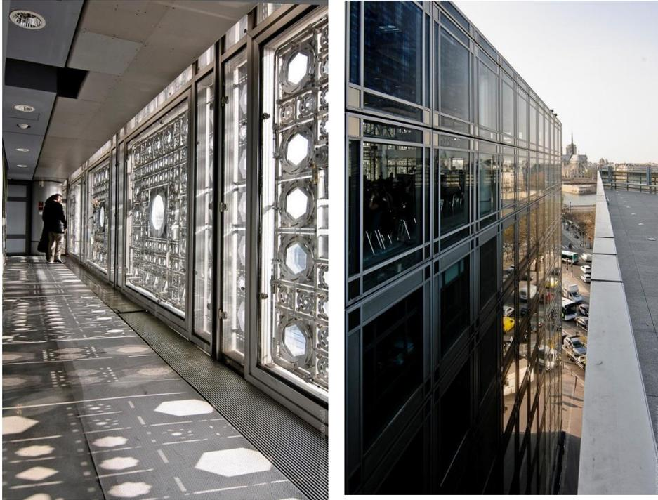
(Figura. 9.12.) (Izquierda). Imagen interior del sistema de fachada. (Figura. 9.13.) (Derecha). Imagen de la parte exterior de la fachada (derecha). Recuperado de: <http://blog.kineticarchitecture.net/2011/01/arab-world-institute/> el 17/11/21
