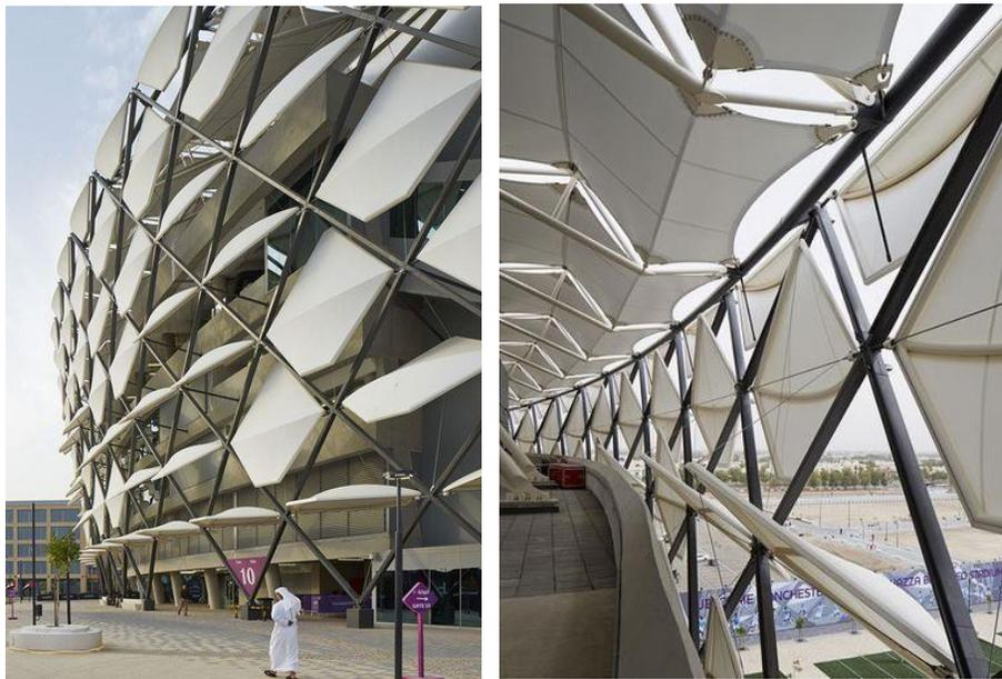
(Figura 8.8.) (Izquierda) Perspectiva del estadio Hazza bin Zayed cuyos paneles en la fachada actúan de manera independiente. (Figura 8.9.) (Derecha) Se aprecia el detalle de las uniones de la membrana con la estructura, la cual le aporta una carga muy baja a la estructura por tener un peso considerablemente bajo. Recuperado de: <https://www.lindner-group.com/en/references/detail/Hazza-bin-Zayed-Stadium-6916/#>
