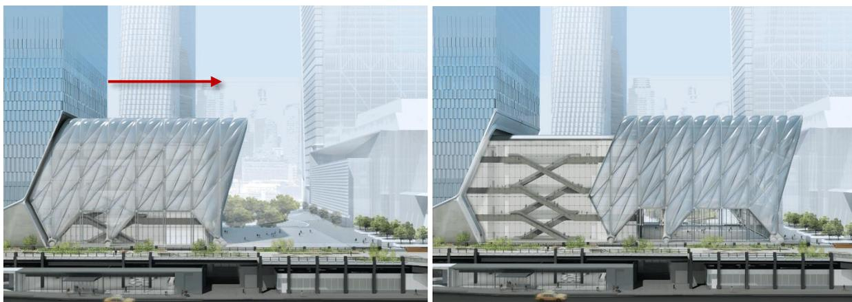
(Figura 9.18) Vista en elevación del proyecto “The Shed” donde se puede apreciar una fachada telescópica (donde se ve cómo la estructura inamovible se acopla dentro de la cobertura). Recuperada de: <https://www.architecturalrecord.com/articles/14044-the-shed-by-diller-scofidio-renfro-with-rockwell-group> el 18/02/20.
