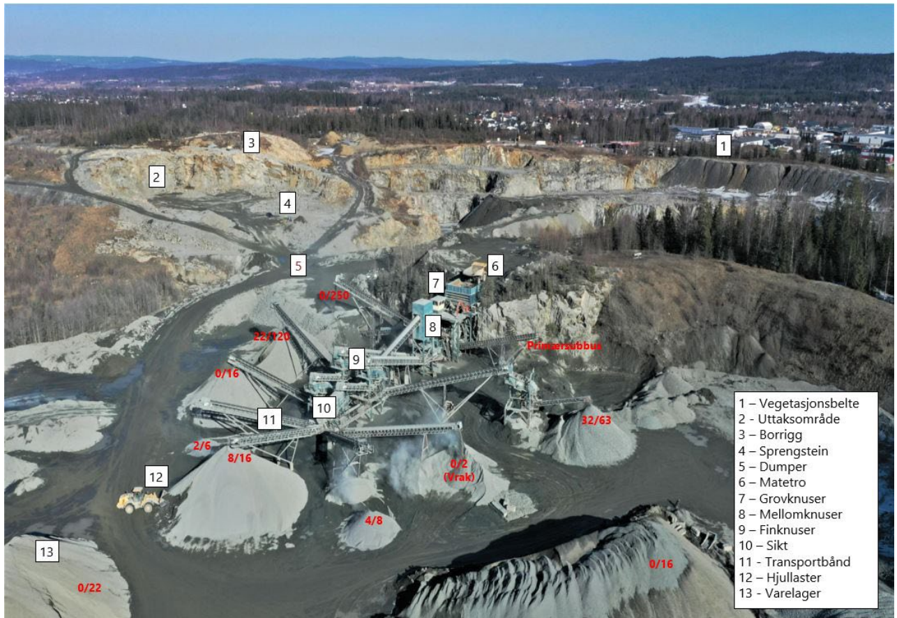
Figur 16. Oversiktsbilde fra Dal Pukkverk. Bildet illustrerer det stasjonære pukkverket og tilhørende soner rundt. Illustrasjon: Feiring.
