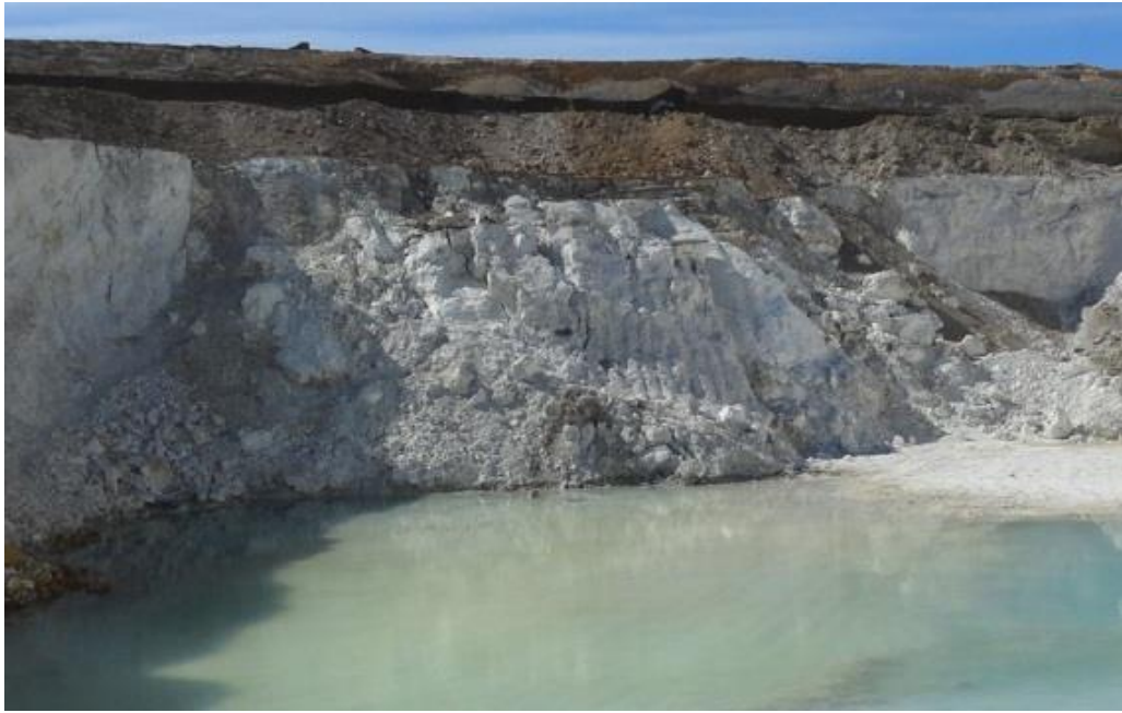
Foto 7: Pared SE, Cuerpo 2, zona derrumbada.
