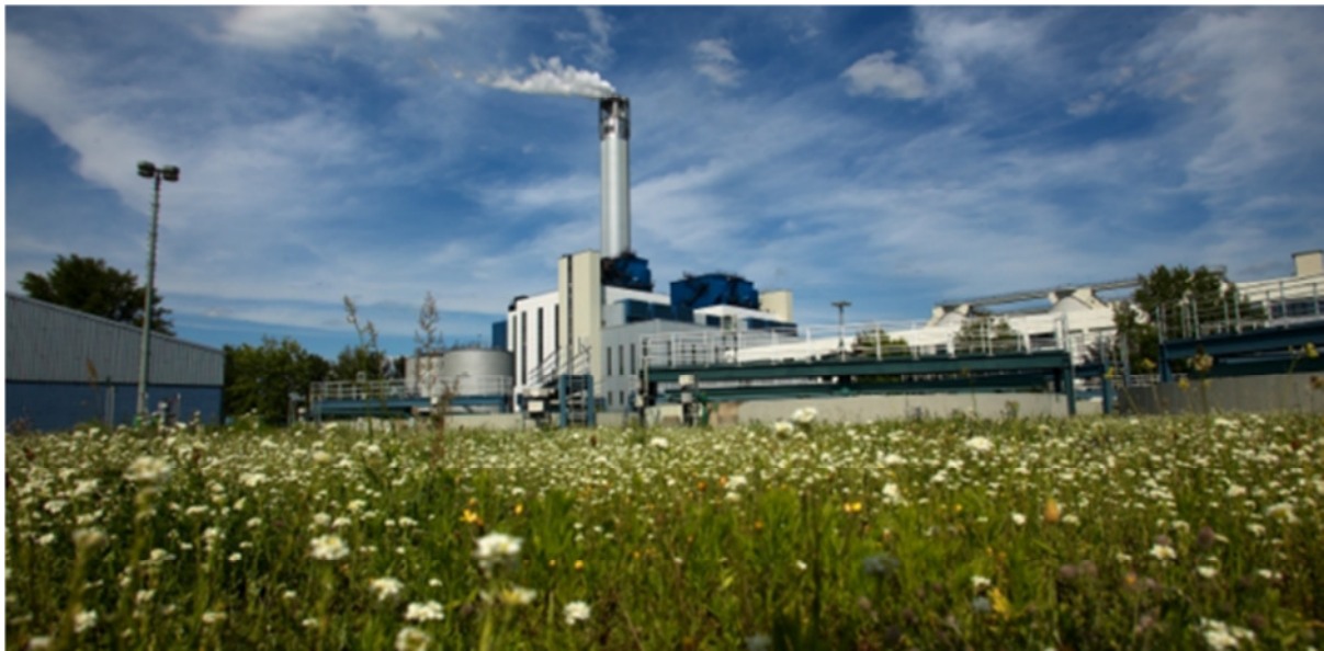
Abbildung 12: Klärschlamm-Monoverbrennungsanlage Ruhleben, Donat ©
