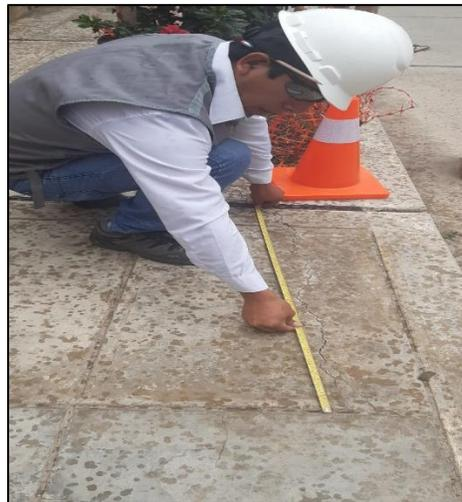
Figura 6: Inspector tomando las medidas del contorno de la unidad
