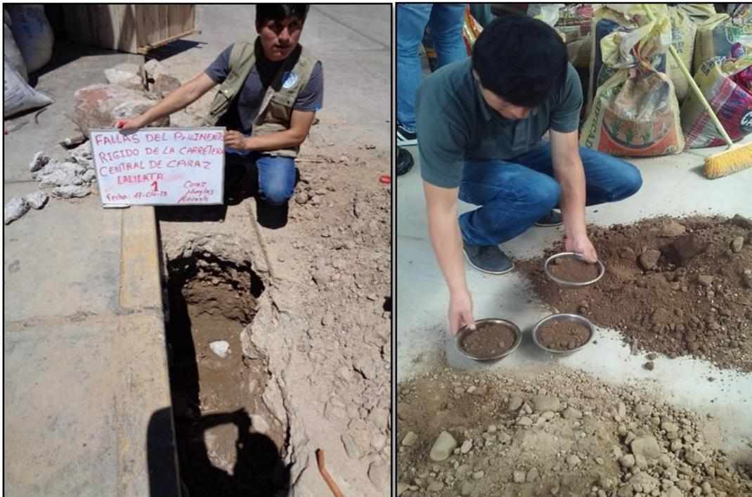
Figura 35: Calicata, obtención de la muestra para sus respectivos ensayos
