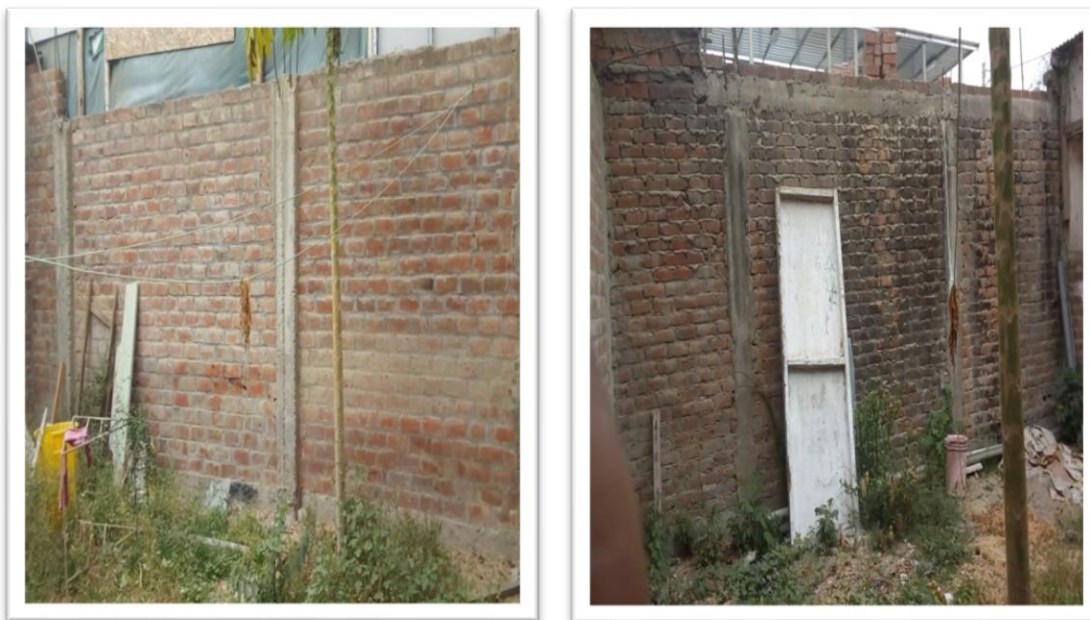
FIGURA N°51.- Muros perimetrales de viviendas aledañas al terreno en análisis
