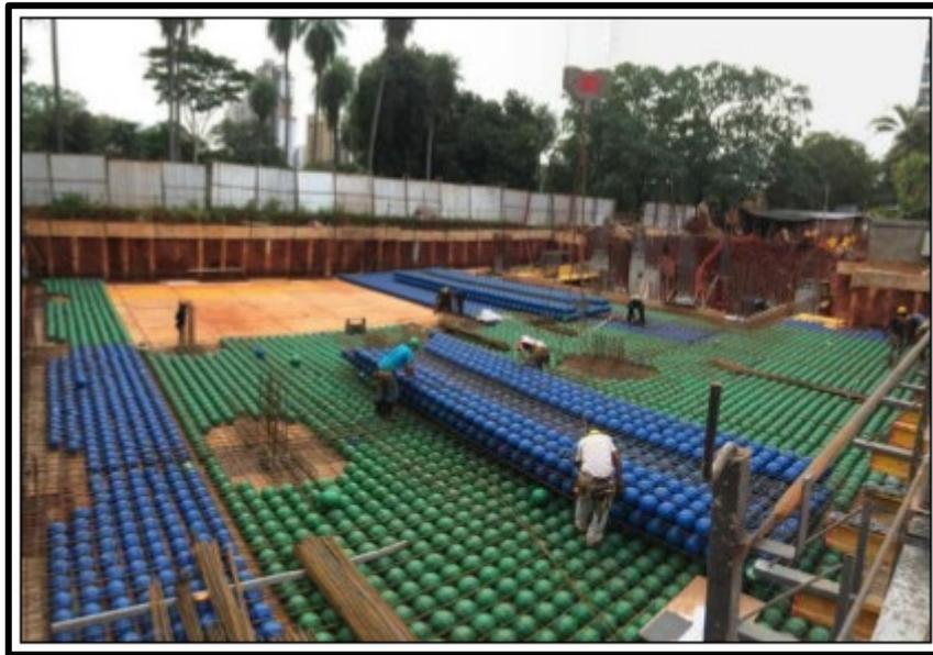
*Figura 12.* Distribución de las esferas de plástico llenas de aire en losas prenova.
