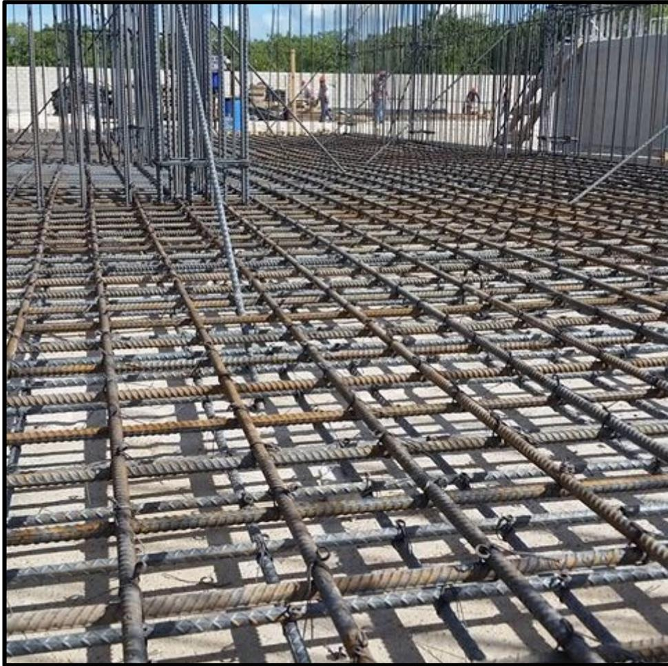
Figura 10. Armadura para losa maciza en dos direcciones. Recuperado de <http://www.prenovaglobal.com/index.php/es/prenova-sistemas-constructivos-sustentables/>
