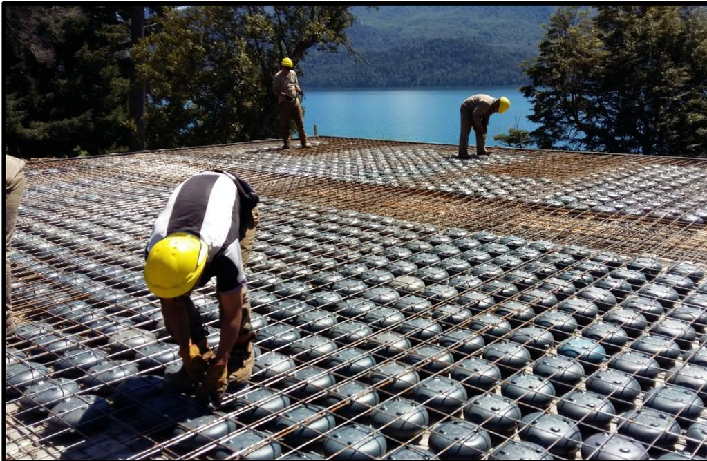
*Figura 13.* Armado de losas de entpiso con esferas de plástico. Recuperado de
