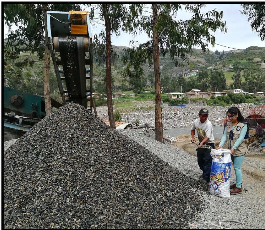
Foto N° 082: Extracción de los agregados.
