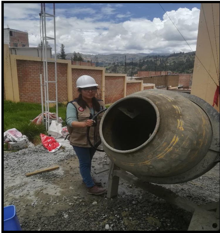
Foto N° 14: Preparación de la mezcla de concreto.
