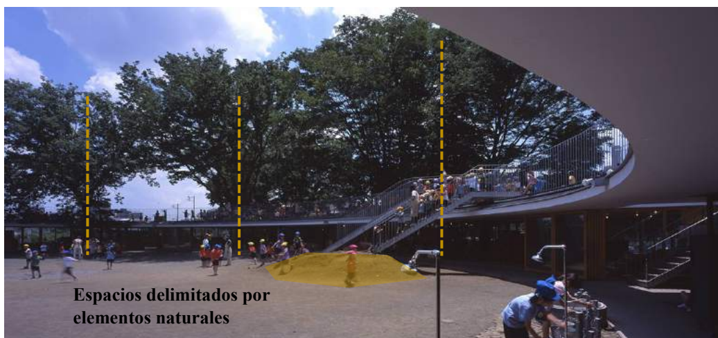
Figura 34. Espacios abiertos del Jardín de Infantes Fuji Fuente: Elaboración propia con base en Tezuka Architects
