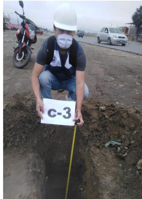
**FIGURA N°13:** Calicata C-3 para extracción de muestra.
